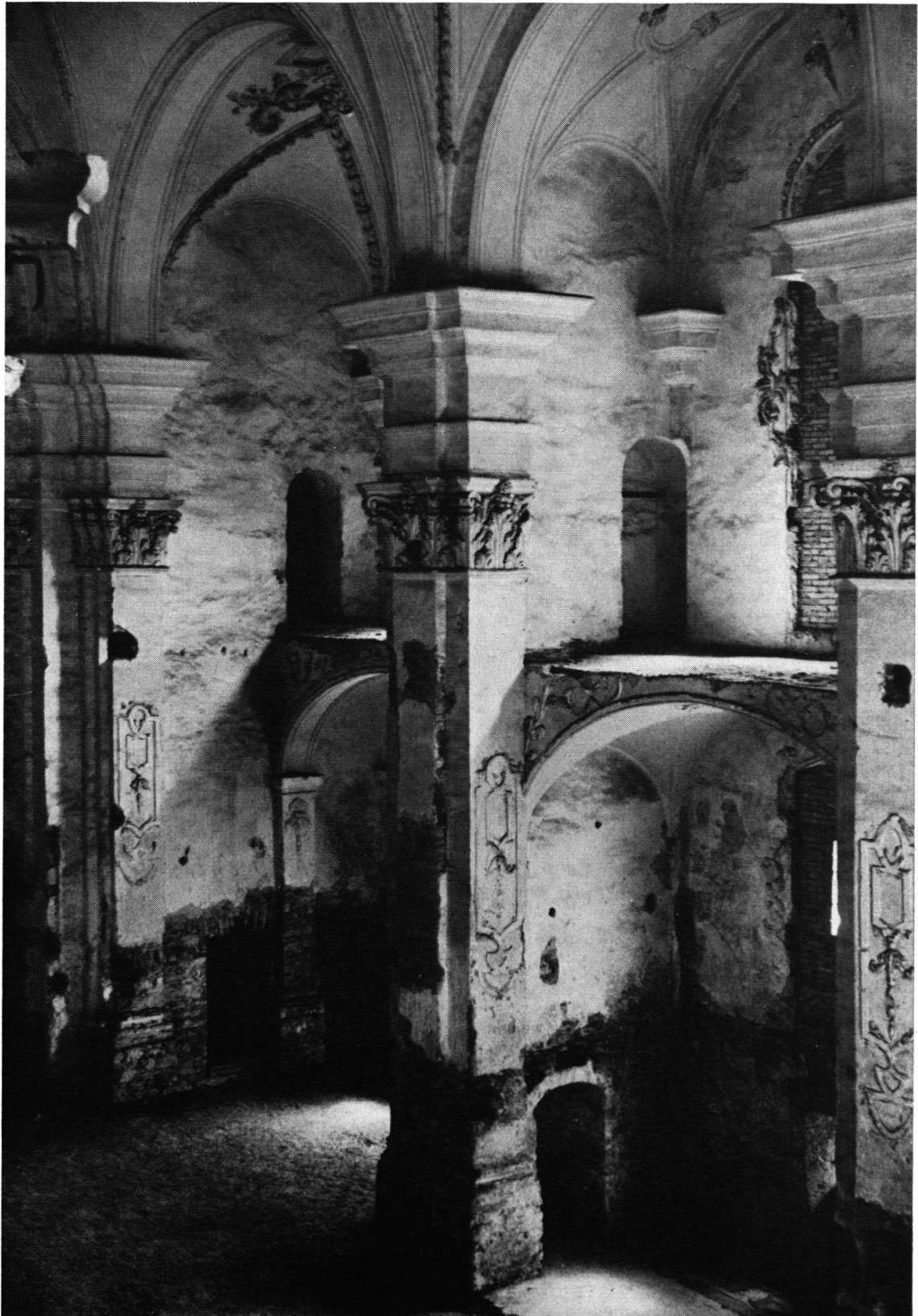
Klosterkirche Bellelay: Zustand vor der Restaurierung. (Photo A. Wyß, Basel)
