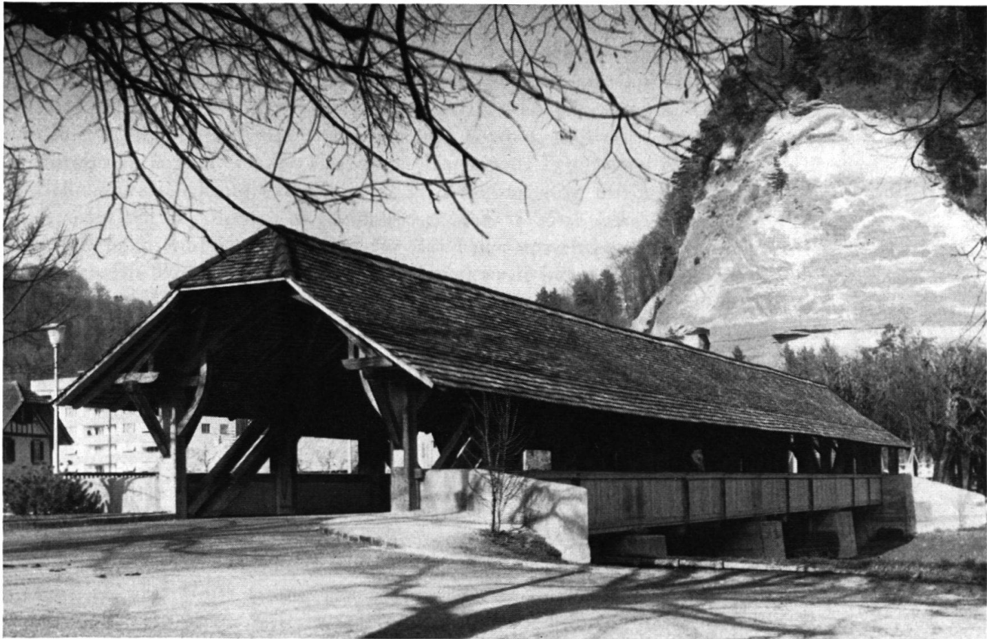
Burgdorf, Innere Wynigenbrücke nach Versetzung. Photo Bauverwaltung Burgdorf
