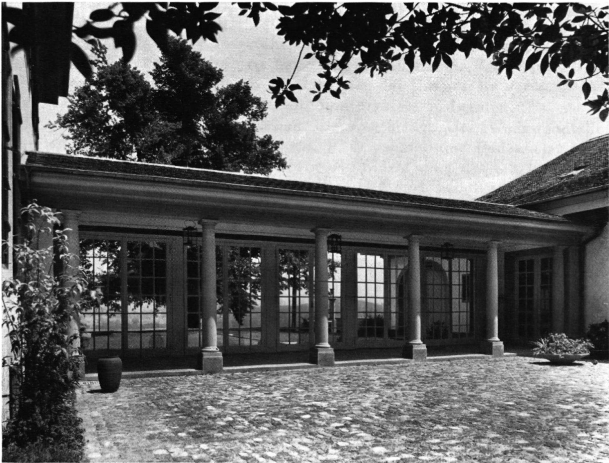
Kehrsatz bei Bern: Der bundesrätliche Landsitz «Lohn». Oben Südfassade und Gartenparterre nach Restaurierung. Unten neuer Verbindungsgang zwischen Hauptgebäude und großem Speisesaal in der Dependenz. Photos Martin Hesse SWB
