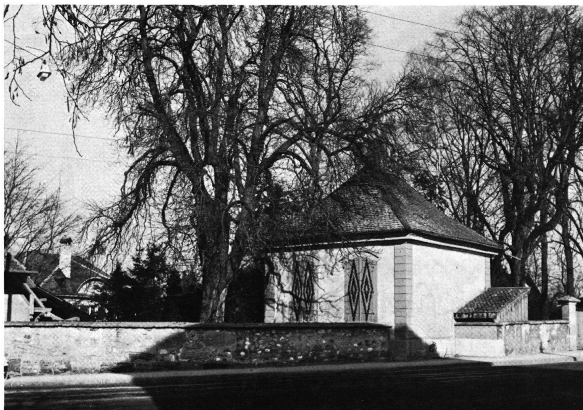
Oben: Der renovierte Wohnstock mit Peristyl des ehemaligen Gossetgutes
