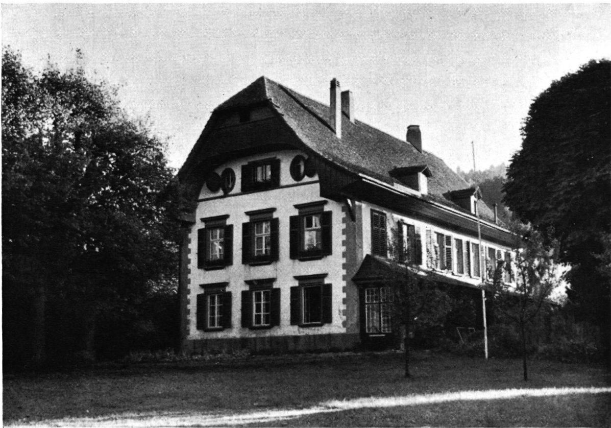
Oben: Ansicht des Hauptgebäudes des Dr. Bouterwekschen Erziehungsanstaltes (zwischen 1834 und 1846). Im Hintergrund das Holzhaus und die Scheune mit Gymnastikraum.
