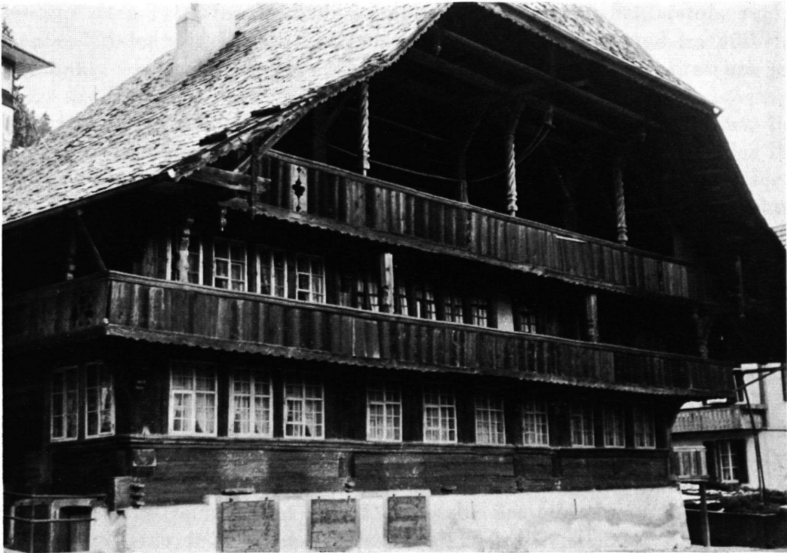
Das Moserhaus von der Straße aus. Die Kellerfenster (drei vorn und eines seitlich) belichteten die Werkstatt der Messerschmiede. Der Estrich ist an der Vorderfront offen.
