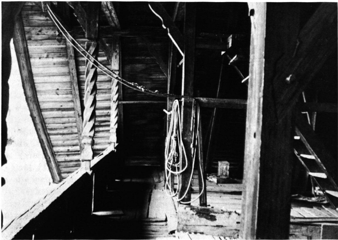
Im Estrich des Moserhauses. Die Treppe beweist, daß die Querbalken nicht nur zum Stützen des Daches dienen. Das Seil gehört zu einem Rollenaufzug.
