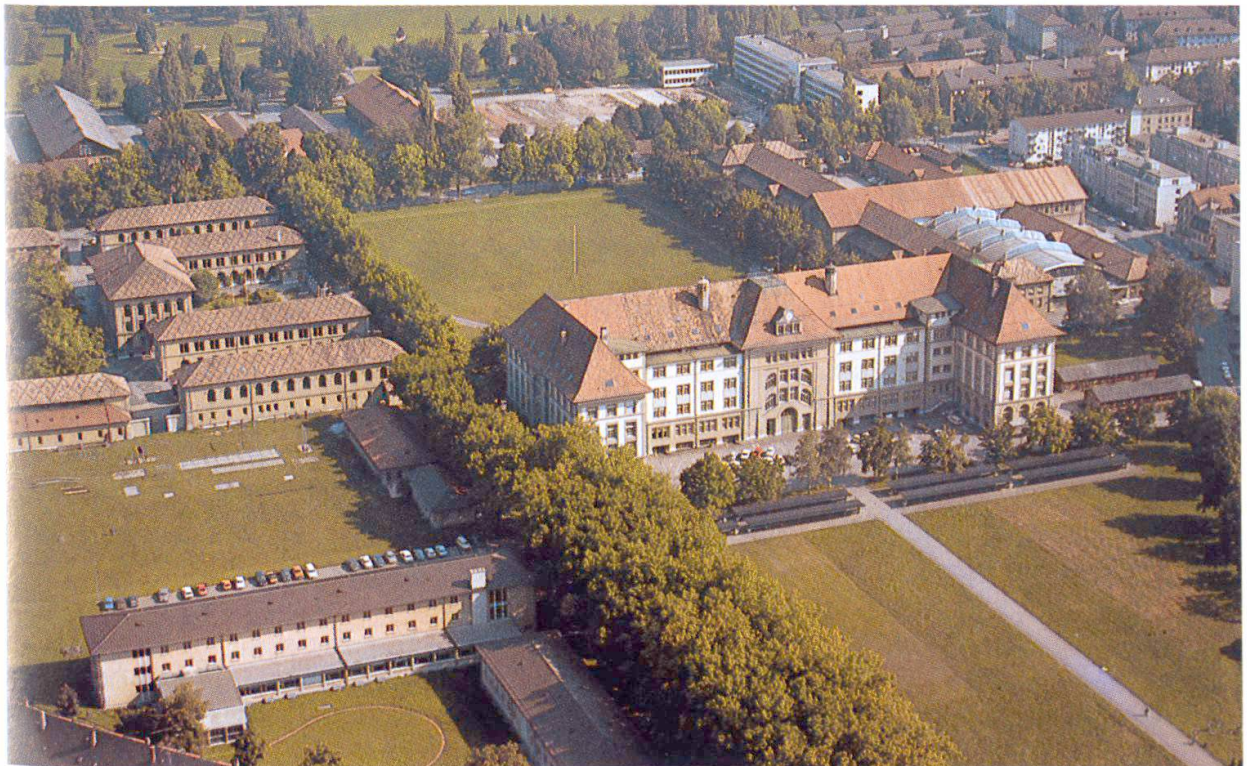
Luftaufnahme der Militäranstalten, 1976.
