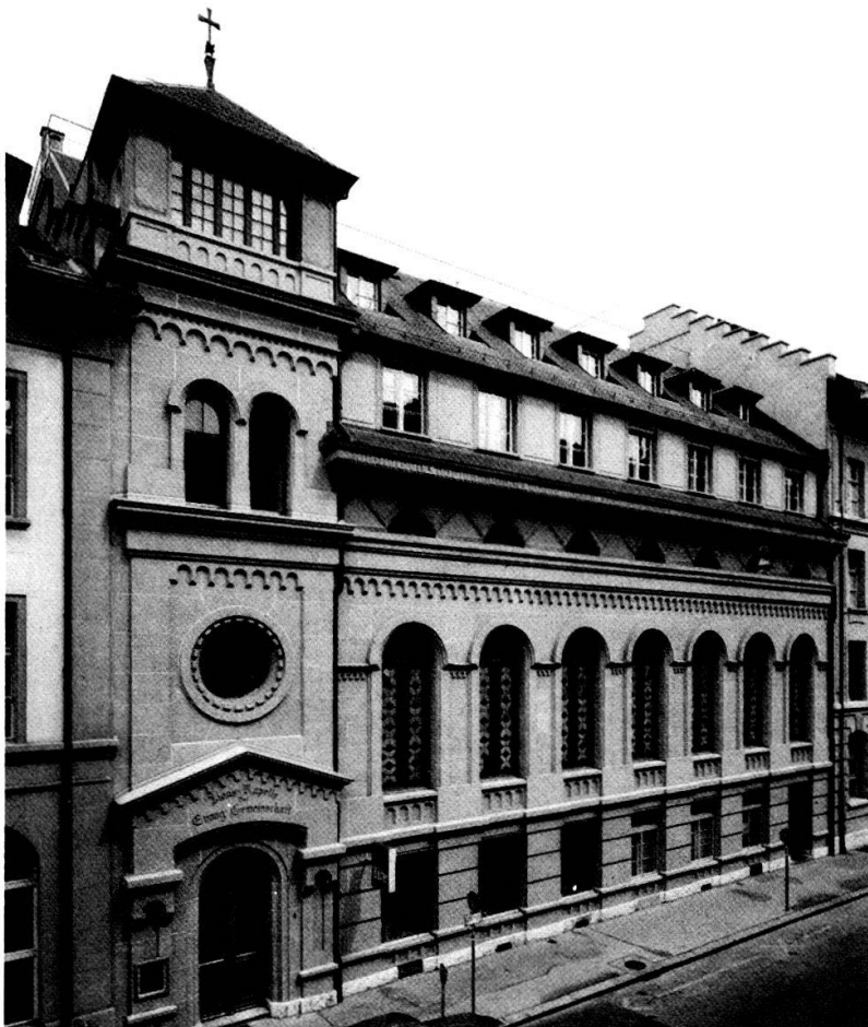
Südfront der Zionskapelle nach der Renovation.
