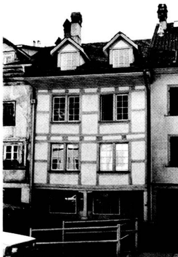
Gerberngasse 44: Gassenfassade, oben vor der Renovation, unten nach Freilegung der Riegkonstruktion und mit neuen Dachaufbauten.
