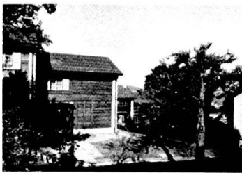
Siedlung Hohliebi: Ostansicht einer Häusergruppe, Zustand 1985.
