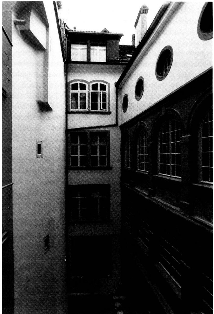
Rathausplatz 1: Der bis in das Erdgeschoss freigelegte Innenhof mit der um das fehlende Joch ergänzten und auf die ursprüngliche Höhe reduzierten Hofgalerie (rechts).
