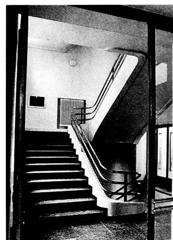
Östliches Treppenhaus des Lory-Spitals, Zustand 1988
