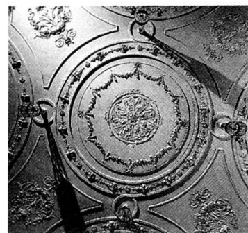
Süd-Foyer des Casino: Ausschnitt der Decke mit rekonstruierten Stukkaturen.
