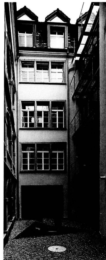
Rathausplatz 1: Innenhof mit modernem Anbau.
