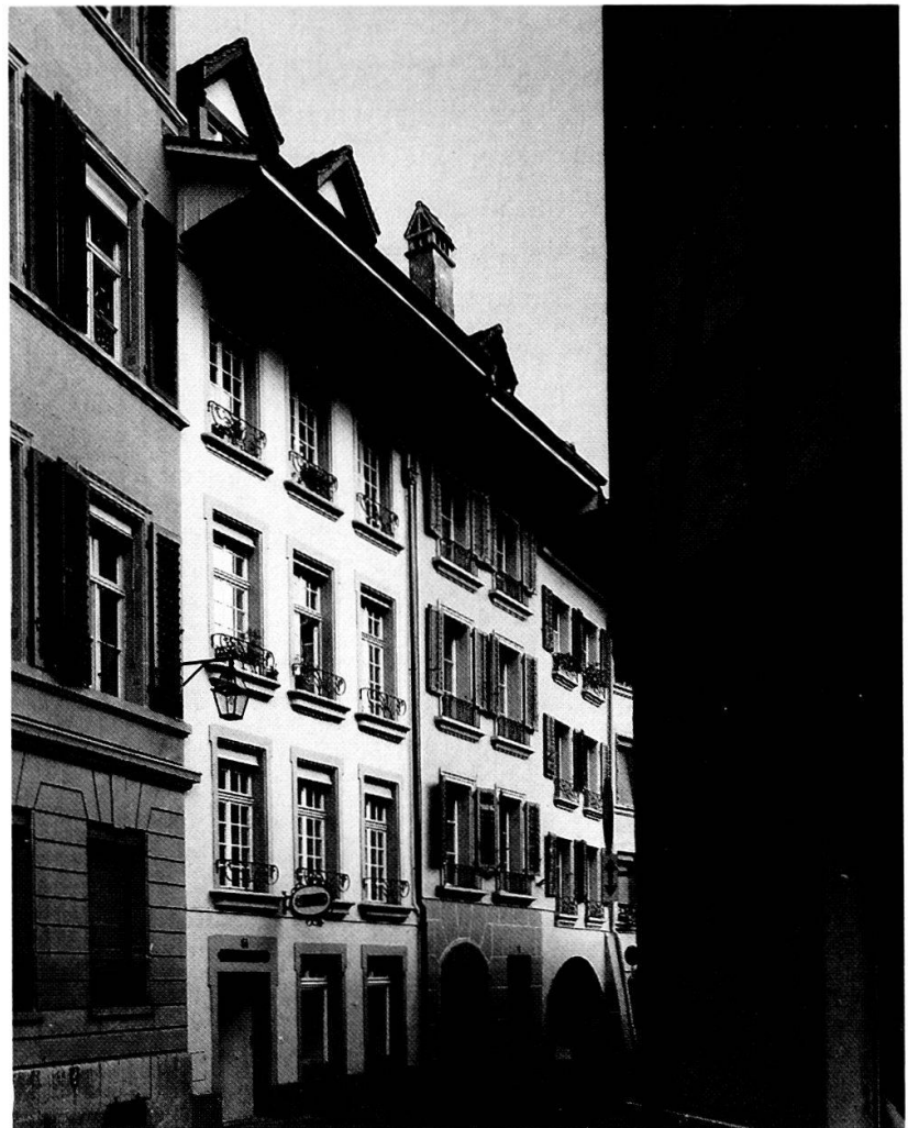
Südfront des Hauses Brunn- gasse 64 nach der Renovation.
