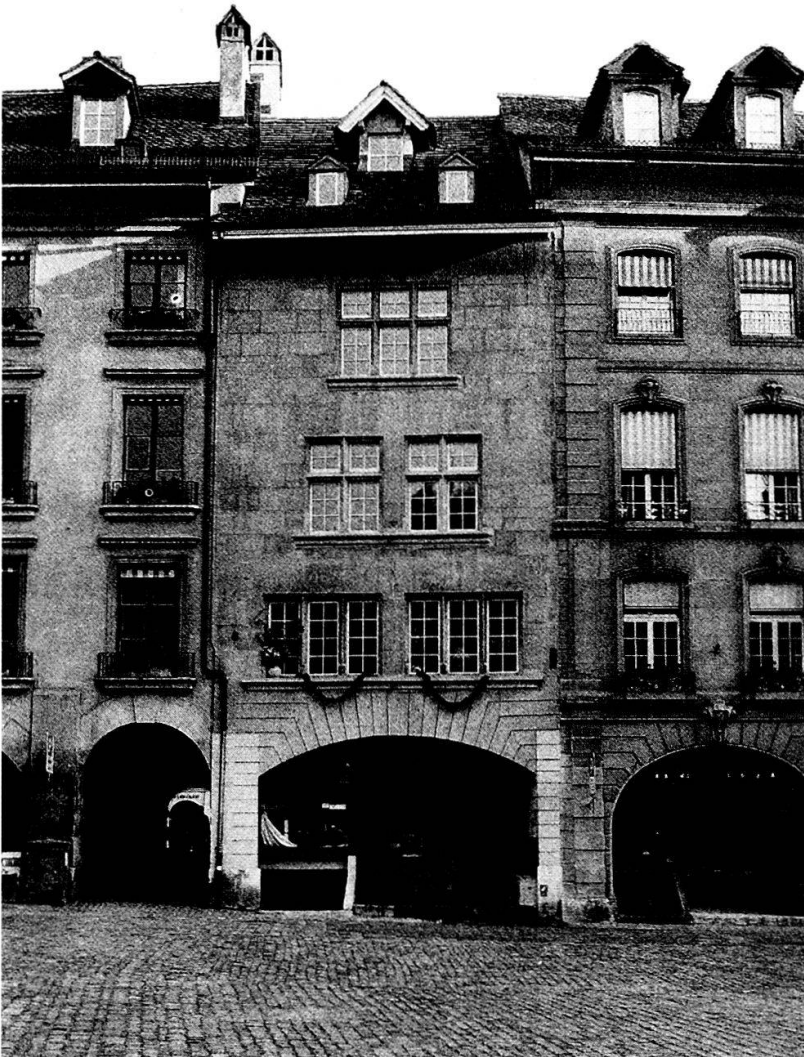
Münstergasse 30, Zustand 1989 mit ergänzten Kreuzstöcken, rekonstruierter Einzelkarnie und ergänzenden Dachgauben.
