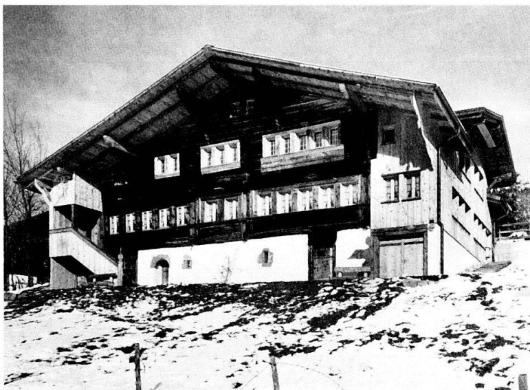
LAUENEN «Alter Spittel», Nr. 233. Mächtiger, breitlagernder Bau, 1. Hälfte 16. Jahrhundert, schlichte Rillen- und Stabzier, Stuben mit «Heidenwelbi». Gesamtanierung, Fassadenrestau- rierung 1990.
