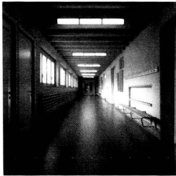
Schulhaus Stapfenacker: Korridor mit nachgerüsteter Beleuchtung und Heizung.
