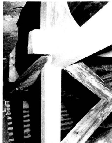
Fricktreppe: Knotenpunkt der Dachkonstruktion, wo alte und neue Hölzer aufeinander treffen.
