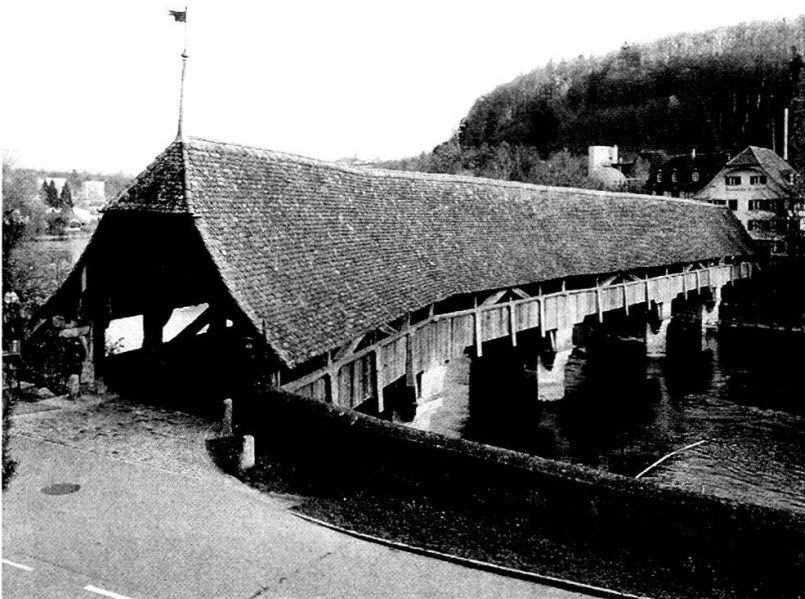
Neubrügg: Sicht von Bremgarten; deutlich erkennbar die Abwicklung.
