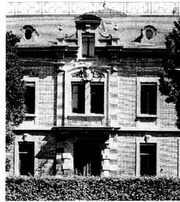
Uni Engehalde: Renoviertes Eingangsportal Neubrückstrasse 10.
