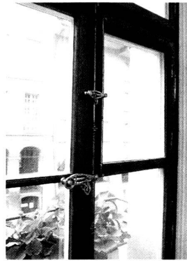
Gerechtigkeitsgasse 25: Originales Fenster mit äusserer Aufdoppelung.
