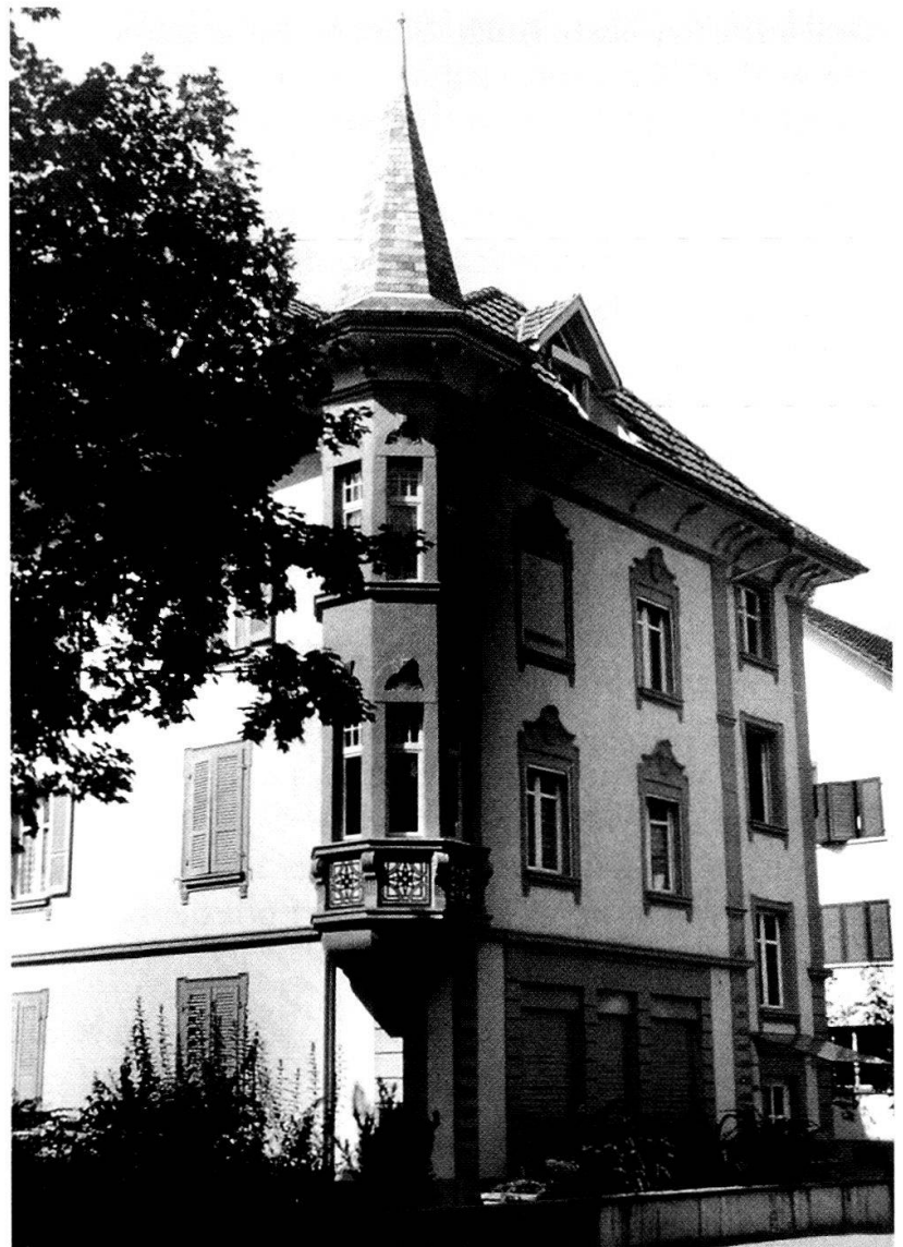
Bümplizstrasse 180 vor dem Umbau.
