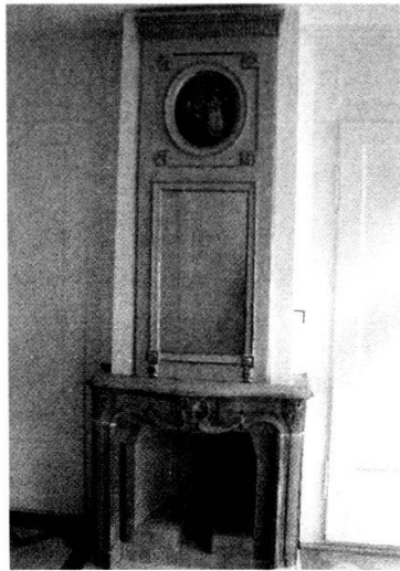
Junkerngasse 20: Cheminée (aus Markt-gasse 44) und Spiegelaufsatz (versetzt vom 2. Obergeschoss Gerechtigkeits-gasse 25) im 2. Obergeschoss
