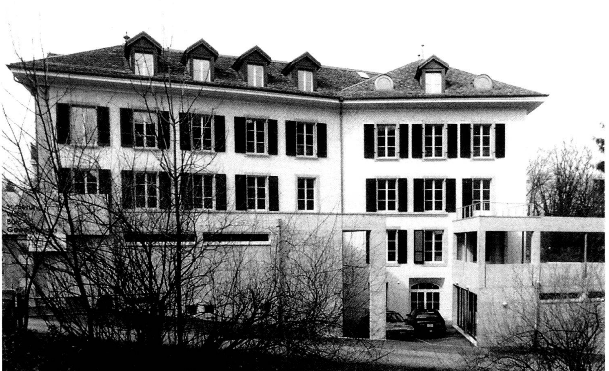
Hodlerstrasse 16: Ostfassade des Wohngebäudes von 1870 mit Neubauten von 1994.
