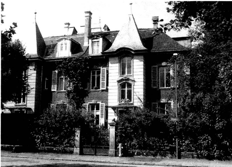
Das Doppelhaus Alpenstrasse 25/27 von der Strassenseite. Die beiden neuen Dachaufbauten wirken in der Dachlandschaft nicht störend.
