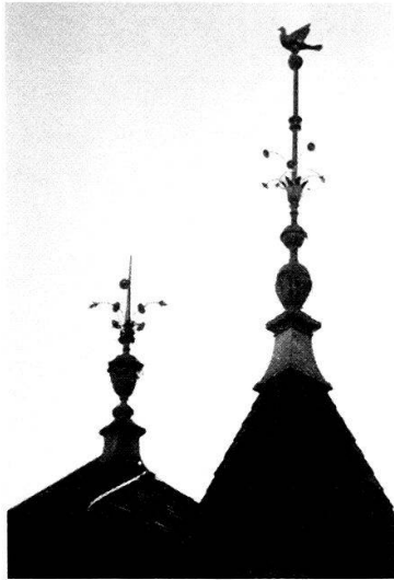
Seftigenstrasse 2: Rekonstruierte Dachzier.
