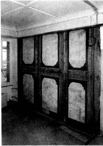
Herrengasse 3: Riegwand im 3. Obergeschoss mit Graufassung des mittleren 17. Jh.
