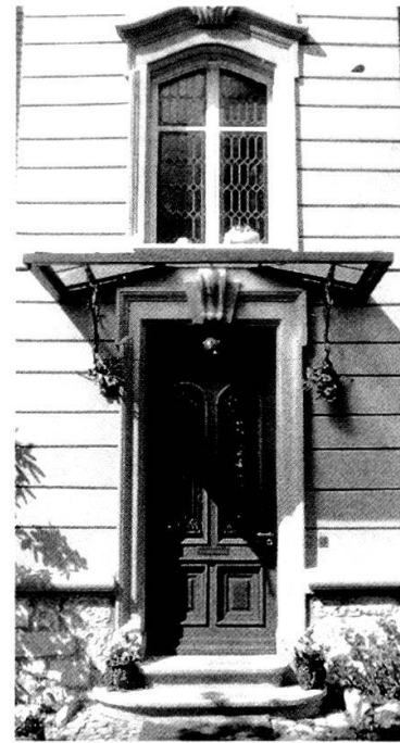
Alpenstrasse 25/27: Detail der Eingangspartie.
