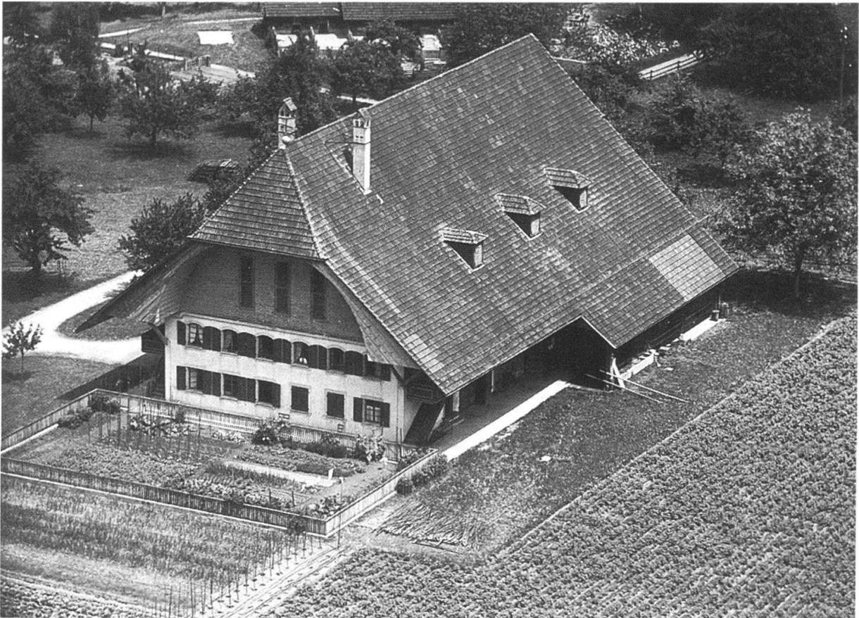
Die 1931 gebaute Scheune mit Wohnteil, welche 1966 wegen eines Kurzschlusses abbrannte (Photographie im Besitz der Familie Gfeller).
