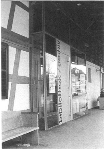
Bernstrasse 75–79: Neue Eingangspartie anstelle des alten Tenntors.
