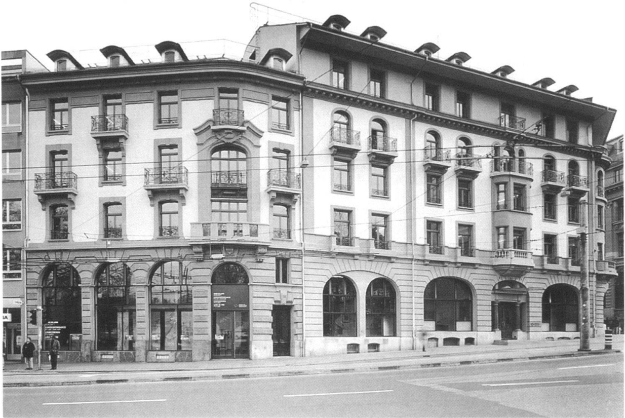
Bollwerk 27, 29: Die beiden Hauptfassaden.
