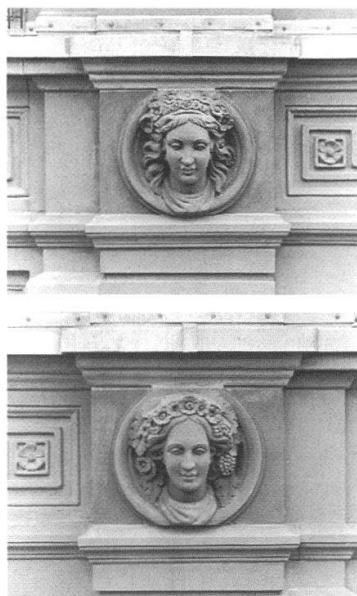
Predigergasse 10: Rekonstruierte und neu gebauene Kopfmedaillons.
