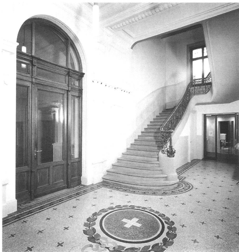
Bollwerk 27: Repräsentatives Haupt- treppenhaus.
