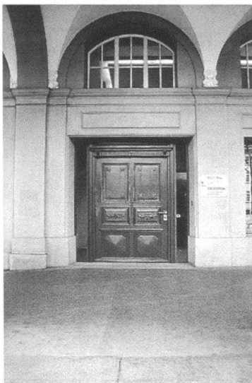
Nydegasse 13: Eine der wiederverwendeten Eingangstüren der «Kocher- häuser».
