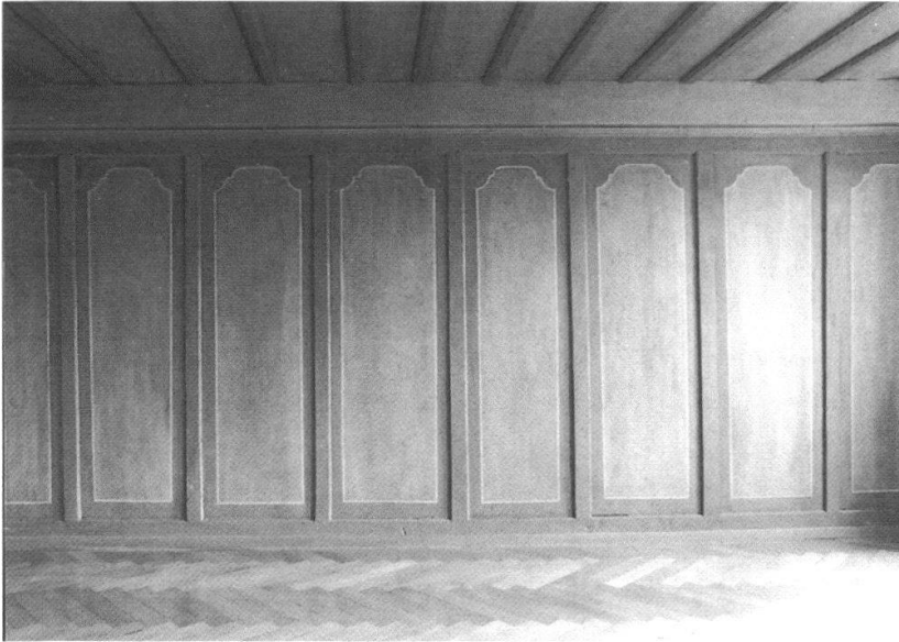
Herrengasse 15: Ausschnitt aus der gefassten Vertäferung der Ostbrand- mauer im Südzimmer des ersten Obergeschosses mit aufgemalten Täferfeldern.
