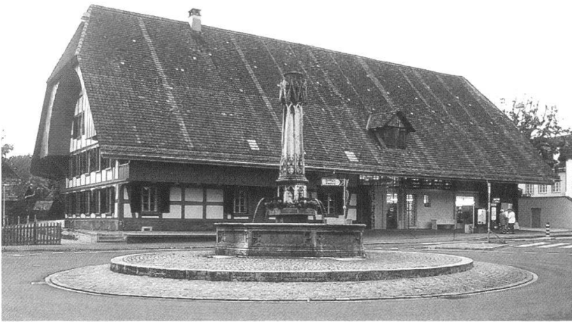
Bernstrasse 75–79: Das mächtige Bauernhaus nach dem Umbau.
