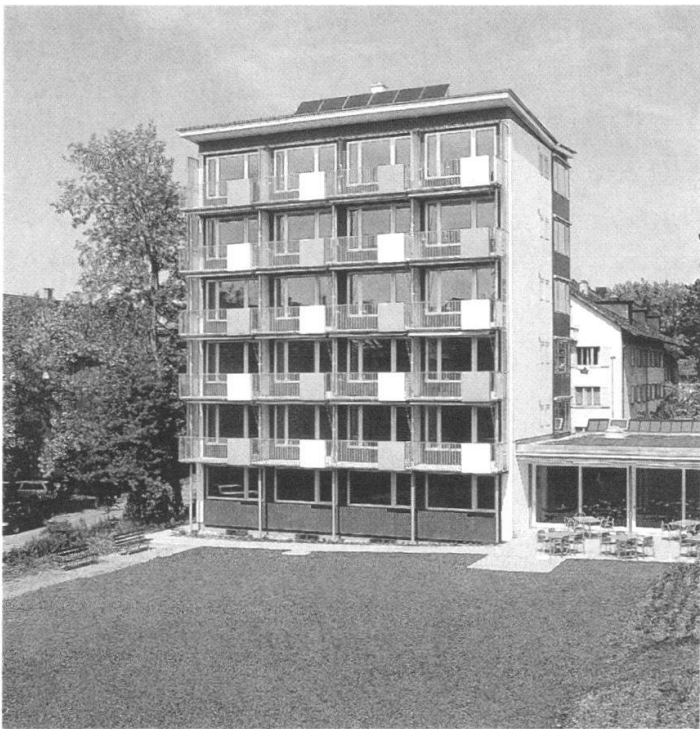
Alterssiedlung Egelmoos, Bürklenstrasse 2: Das 'Hochhaus' vor und nach dem Umbau.
