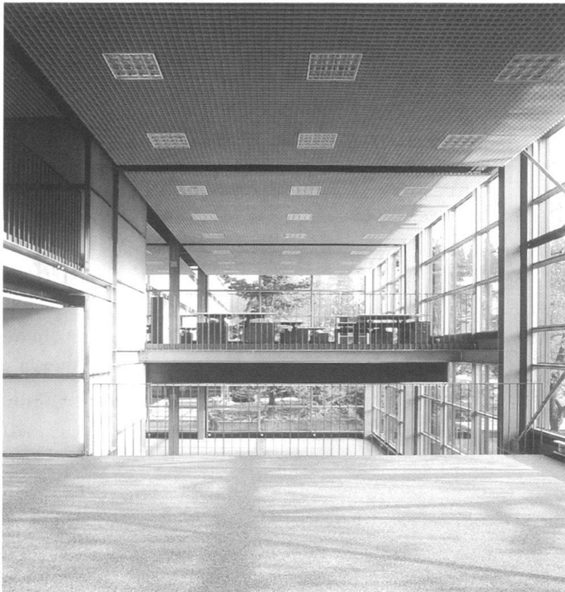
Weltpoststrasse 17: Innenraum vor und nach dem Umbau.
