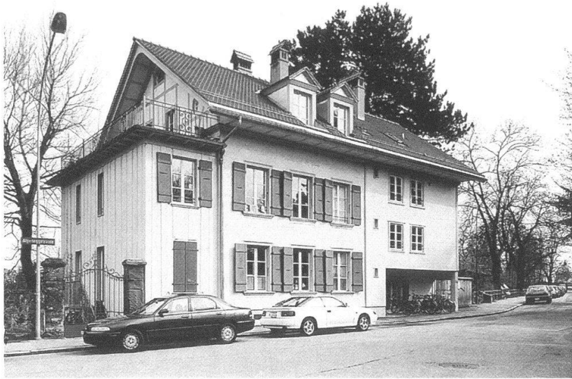
Alpeneggstrasse 10: Strassenansicht mit instand gestellter Fassade und wieder aufgebautem Dach mit Biberschwanzziegeln.
