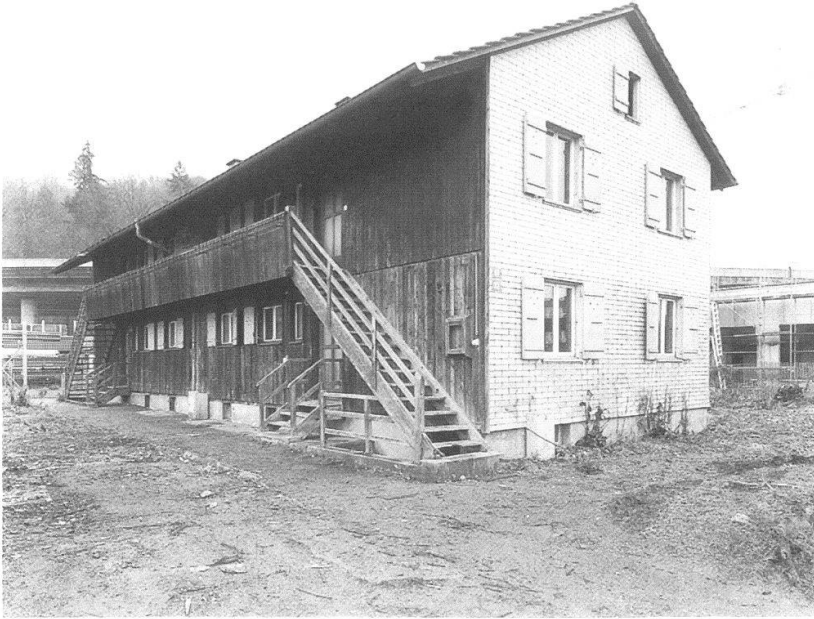
Wangenstrasse 95/97: Abbruch der letzten so genannten Export-Häuser.
