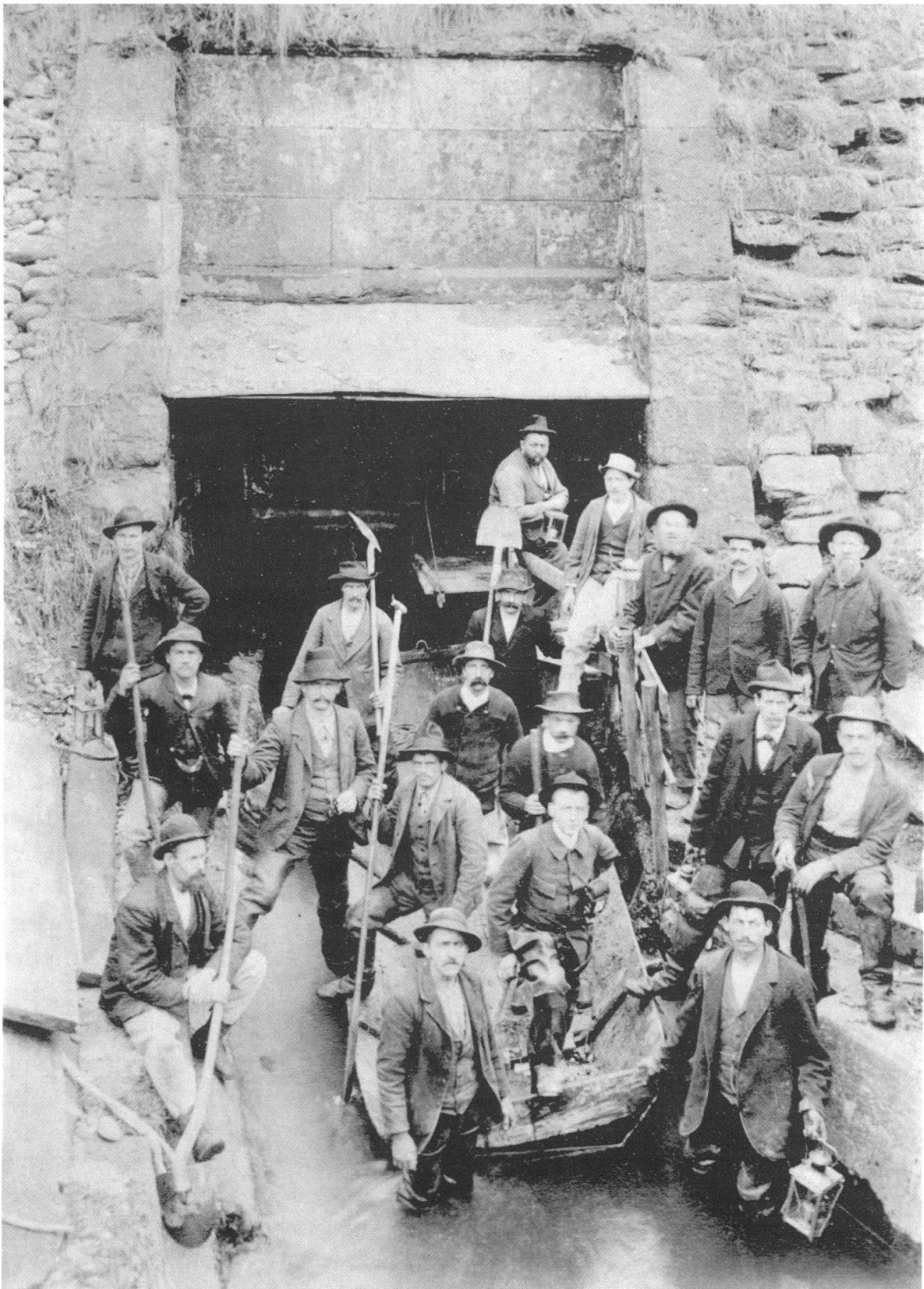
Abb. 16 Felsenauer beim Auslauf des Kraftwerkstollens um 1910. Im Winter wurden bei niedrigem Wasserstand eine Anzahl Arbeiter zum «Grienen» abdelegiert. Sie mussten den Kies, der sich im Lauf des Jahres auf der Sohle des Stollens abgelagert hatte, herauschaufeln. Diese Arbeit war unbeliebt und ungesund, weil man bei schlechten Lichtverhältnissen mit hohen Stiefeln im kalten Wasser stehen musste. Zuvorderst im Boot steht Guido Werder, der jüngste Bruder des Direktors, mit einer Taschenlampe ausgerüstet.
