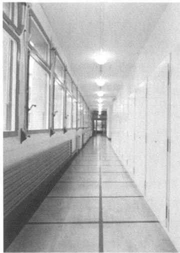
Kantonales Laboratorium, Baltzerstrasse 5: Korridorzone mit sanierten Einbauten und Befens-terung sowie erhaltener Restbestand der Rohr-heizung und des Euböolith-bodenbelages.
