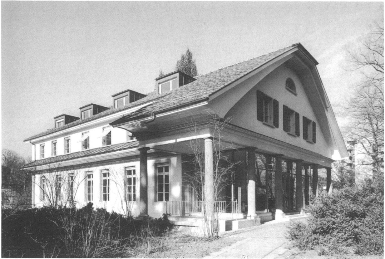
Bellevue Zieglerspital, Morillonstrasse 87: Gesamtansicht Nord- ost mit Peristylanbau Ende 18. Jahrhundert, Aufstockung 1935 und Lukarnenaufbauten 2003.
