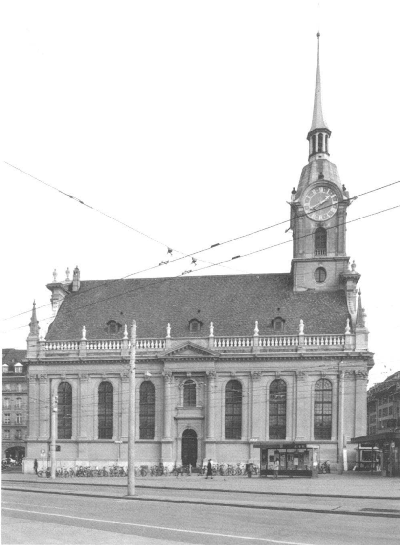
Heiliggeistkirche, Spitalgasse 44: Die 2002 restaurierte Westfassade, ohne den geplanten «Baldachin».
