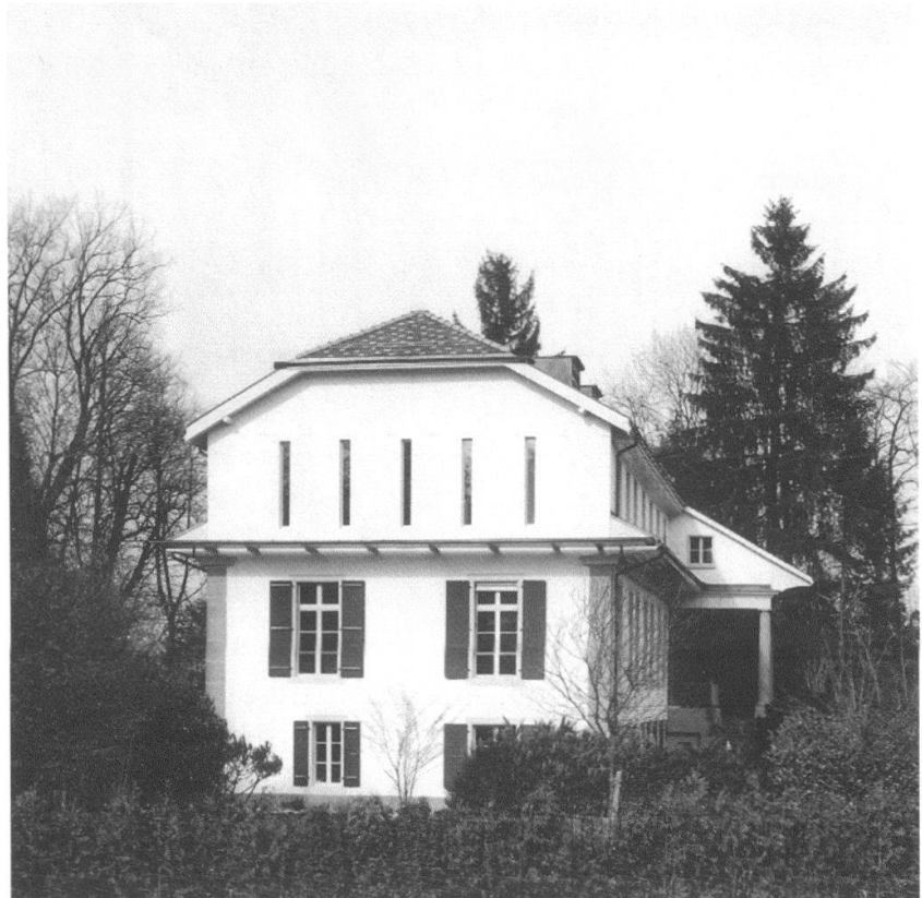
Bellevue: Fassade Süd mit re- konstruierten Fenster- öffnungen im Erd- und Obergeschoss, neuem Vor- dach und Fensterschlitz im Dachgeschoss.
