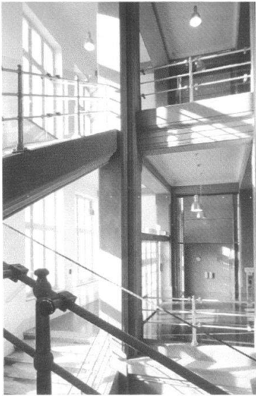
Reithalle und Kaserne: Haupttreppenhaus der Ka- serne mit nachgerüsteten Geländern.
