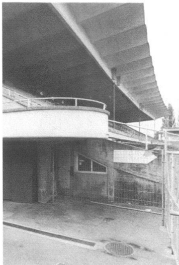
Stadion Wankdorf: Tribüne mit Balkon.
