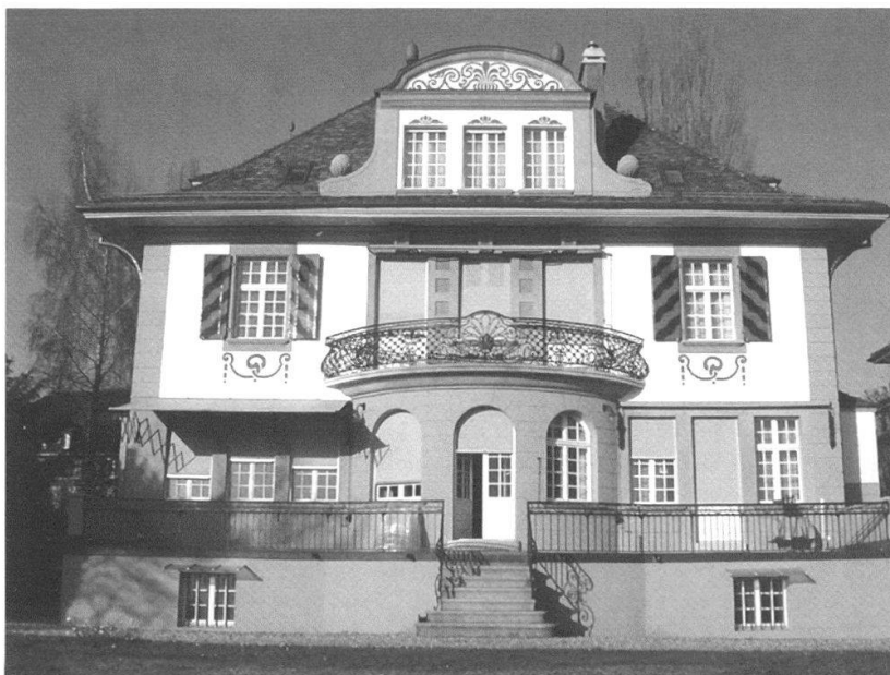
Villa Ulmenberg, Schänzlistrasse 45: Gesamtaufnahme der Süd- fassade mit restaurierten Sgraffiti.
