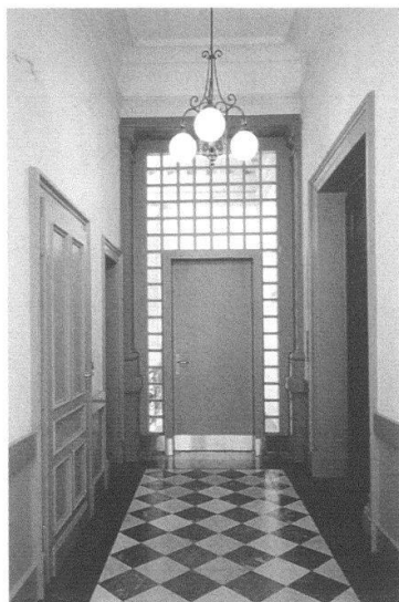
Parlamentsgebäude: Neue Tür als Korridor- abschluss.
