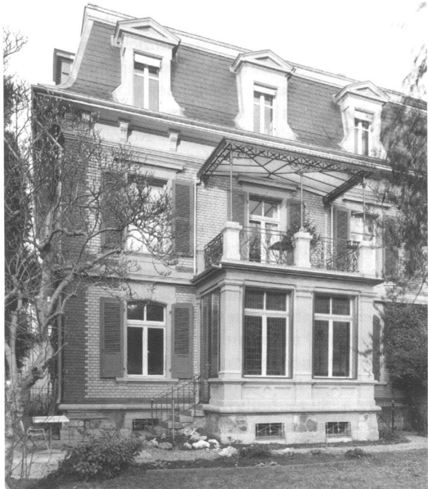
Erlachstrasse 16 A: Gartenfront nach der Fassaden- und Dachreno- vation. Die Veranda mit neuer Schutzverglasung anstelle der traditionellen Vorfenster.
