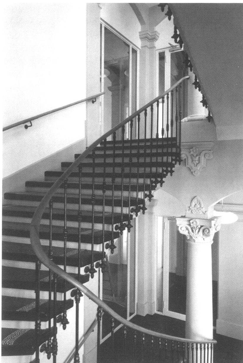
Ehemaliges Frauenspital: Treppenhaus Ost von 1876 mit neuen Brandschutz- abschlüssen.
