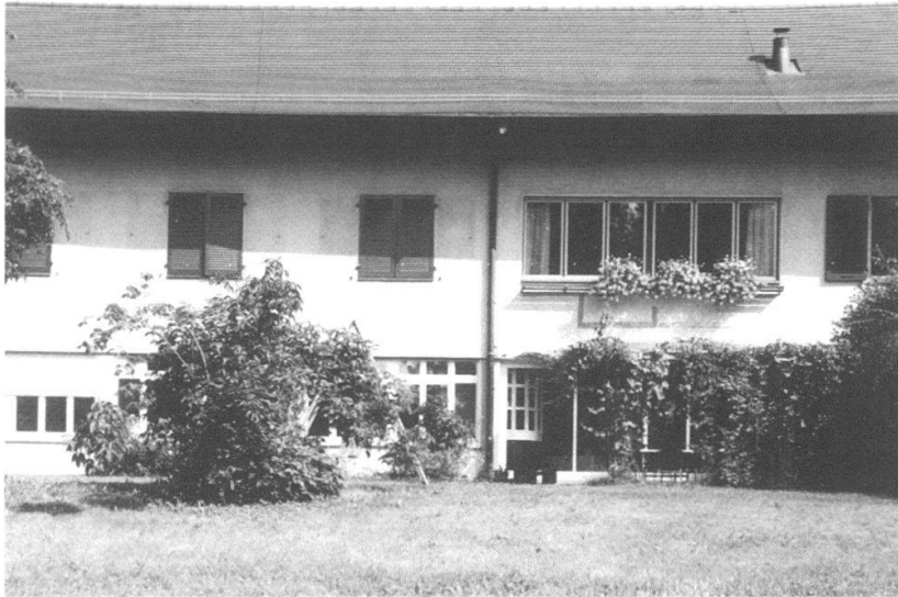
Bürgerliches Jugend- wohnheim, Melchenbühlweg 8: Ansicht der Südfassade mit der intakten Dachfläche.
