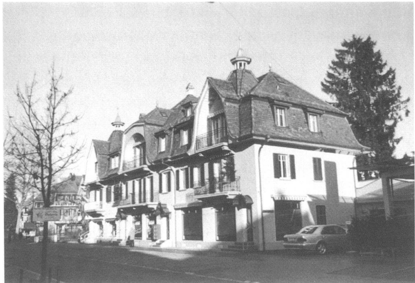
Bümplizstrasse 111–115: Gesamtansicht der Häuser- zeile aus dem Jahr 1905 nach der Restaurierung von 2001.
