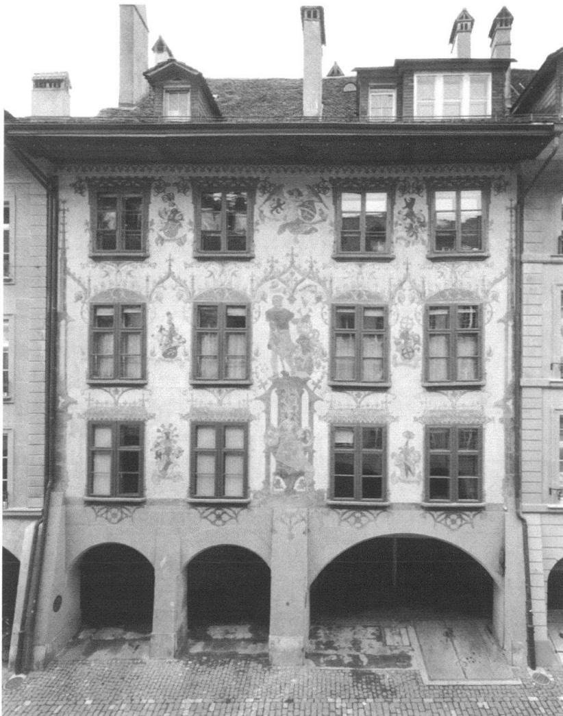
Zeerlederhaus, Junkerngasse 51: Gassenfassade mit Freskenzyklus von Rudolf Mürger. Zustand nach der Restaurierung.
