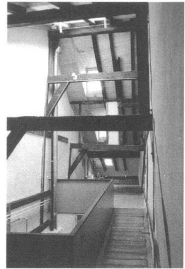
Schiffflaube 32: Dachraum gegen Süden mit Treppenhaus-Lichthof im Vordergrund.
