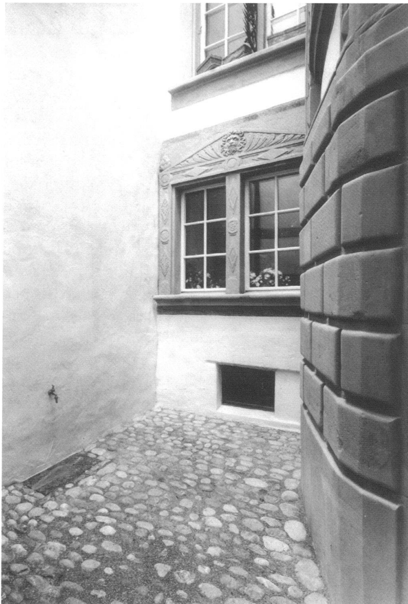
Gerechtigkeitgasse 33: Innenhof mit Erdgeschoss- fassade, Rustikasockel des Treppenturms und neuer Pflasterung.
