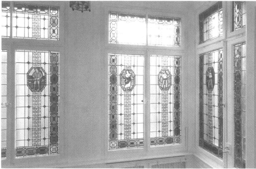
Erlachstrasse 16 A: Ausschnitt der Veranda mit der Jugendstilverglasung von 1915 nach der Restau- rierung.
