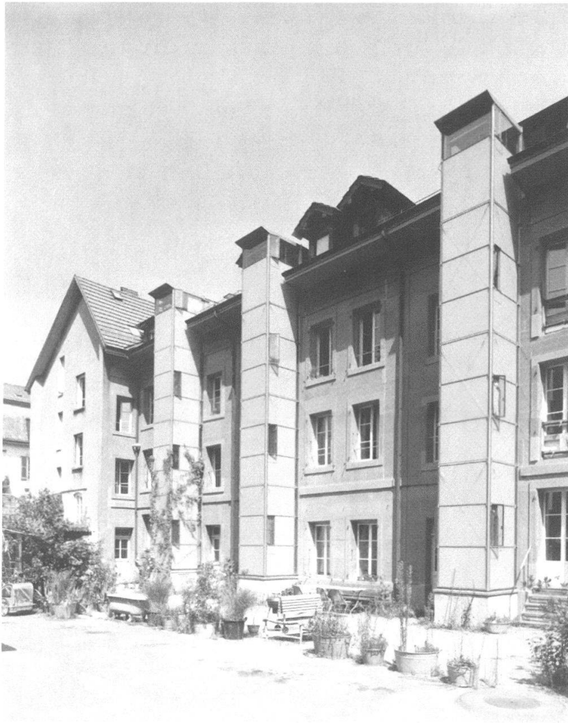
Turnweg 13–19: Die Hoffassade mit den neuen Badezimmertürmen.
