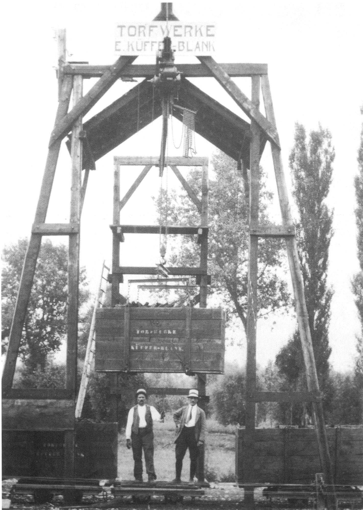
Abb. 10 Mit dieser Holzcontainer-Hebeanlage lud die Firma Ernst Küffer-Blank die oben offenen Container ab den Rollwagen auf Lastwagen, die den Torf nach Bern brachten, und auf Pferdefuhrwerke, die nach Neuenburg fuhren. Auf der Foto aus der Zeit des Ersten Weltkriegs präsentiert sich Ernst Küffer-Blank mit Hut, Krawatte und Reithosen; links neben ihm steht ein Arbeiter. Auf den Geleisen ganz vorne transportierte das Unternehmen die Container vom Torffeld zur Hebeanlage und zurück.
