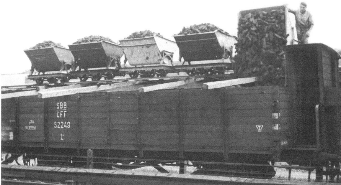
Abb. 14 Umladerampe am Bahnhof Ins um 1943. Hinter den SBB-Güterwagen befindet sich ein erhöhtes Geleise, auf dem fünf voll geladene, grosse Torfwagen stehen. Ganz rechts leert ein Arbeiter die Torfstücke in den Güterwagen der Bahn.
