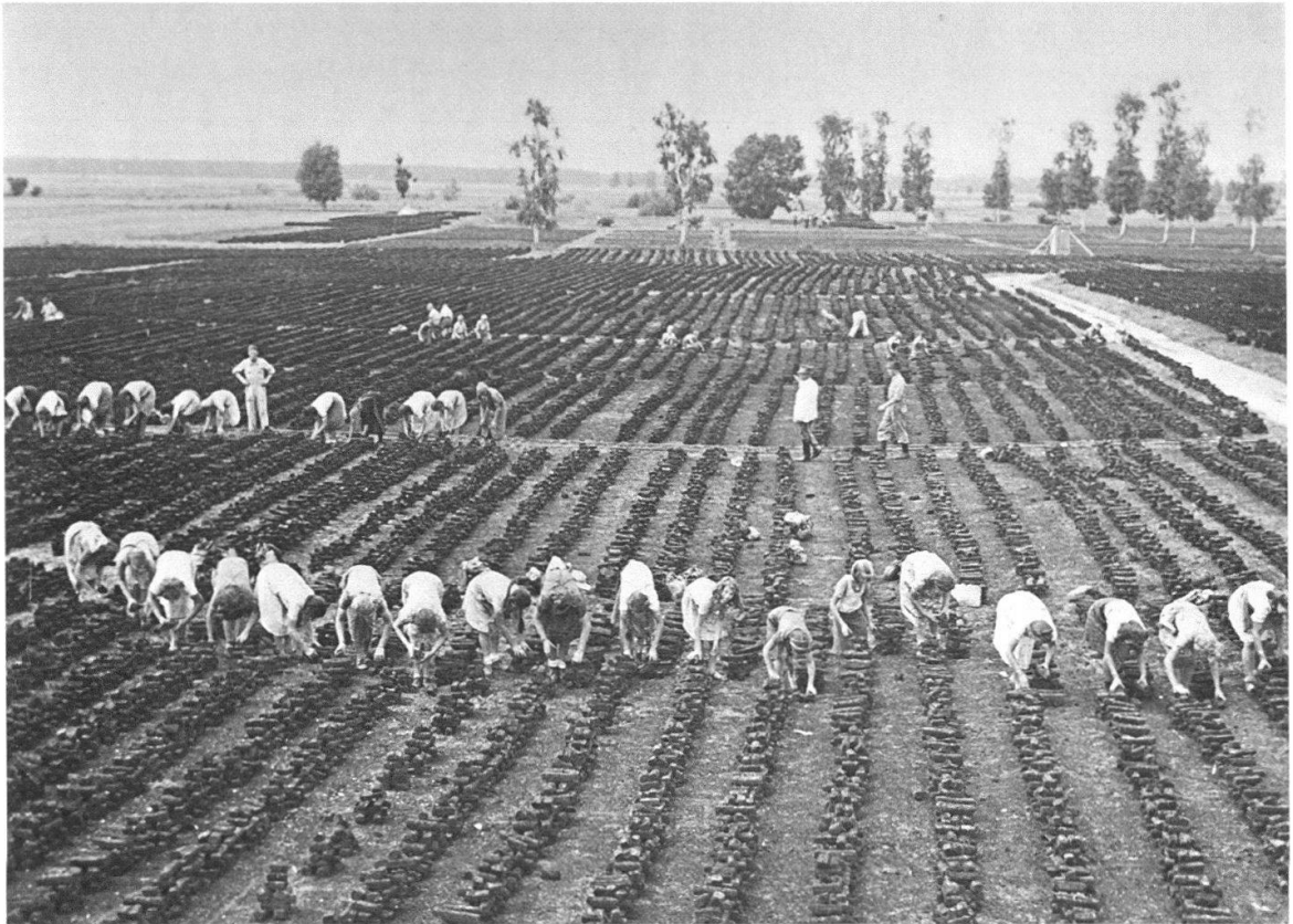
Abb. 13 Trocknungsflächen bei Ins, so weit das Auge reicht. Die Frauen wenden die in Reihen gelagerten «Höckli» (Torfstapel) von oben nach unten, damit alle Turben ganz austrocknen. Im Zweiten Weltkrieg erledigten Frauen diese Arbeit, weil die Männer im Militärdienst waren.
