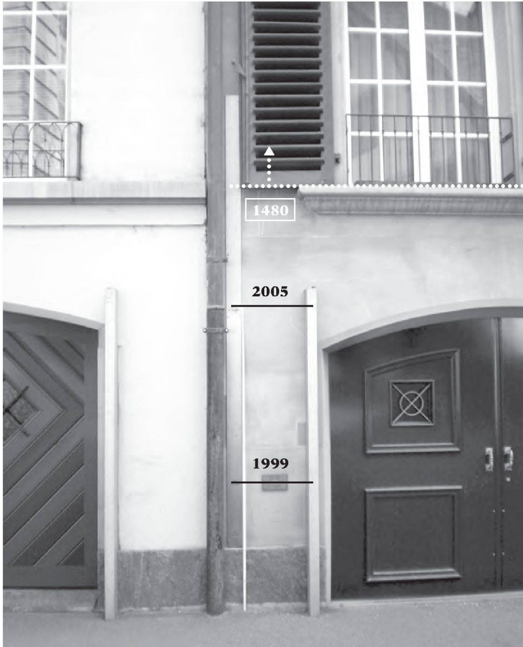
Abb. 2: Hochwassermarken der Überschwemmungen vom 15. Mai 1999 und vom 22. August 2005 an der Gerberngasse 3/5 im Berner Mattequartier im Vergleich mit dem Jahrtausendhochwasser vom 31. Juli/1. August 1480. Bei einem Abfluss von rund 600 \text{ m}^3/\text{sec} war der Wasserspiegel 2005 als Folge von Stau durch Schwemmholz 1.10 m höher als 1999. Für das Ereignis von 1480 ist dies nicht belegt. Damals schwammen die Möbel im ersten Stock bereits in der Nacht und das Wasser stieg bis zum Mittag weiter. – Foto Oliver Wetter.
