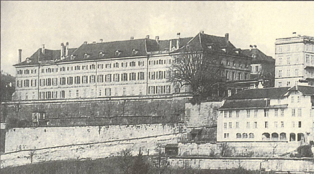
Das Inselspital: Im Neubau, ein Temperabild von Johann Grimm von 1724 und fotografiert 1888 kurz vor dem Abbruch.
