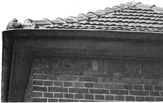
Abb. 2 Walmanfänger auf dem Dach der Ziegelei Beckers in Krefeld-Hüls, aus der Form Abb. 1/1 – 3.
