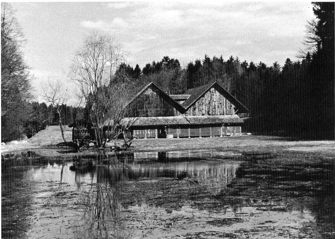
Abb. 33 Ziegelhütte «Meienberg» im Herren- wald in Cham, erbaut um 1850.
