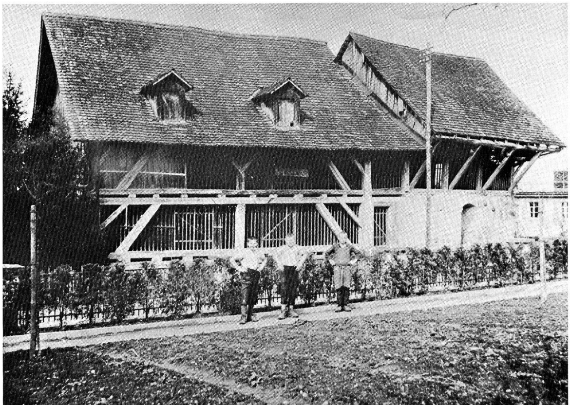
Abb. 18 Ehemalige Stadtziegelei an der Artherstrasse 30 in Zug (1634 – 1929)
