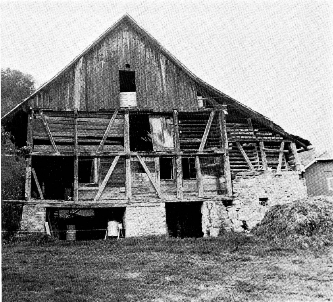
Abb. 1 Ziegelhütte mit offenem Kammerofen in Siebnen- Galgenen SZ. Erbaut 1827. In Betrieb bis um 1880. Aufnahme von N/1987.
