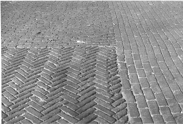
Abb. 3 Verschiedene Verlegungs- arten.
