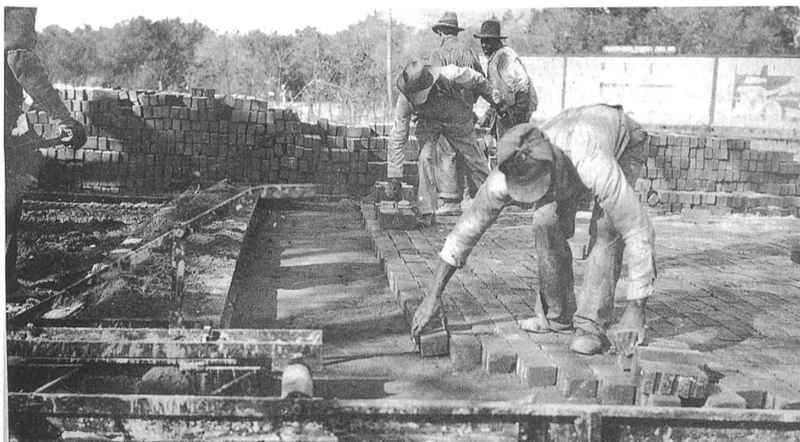
Abb. 5 Das Legen der Pflaster- steine auf einer Land- strasse, Geary County, Kansas, um 1915.
