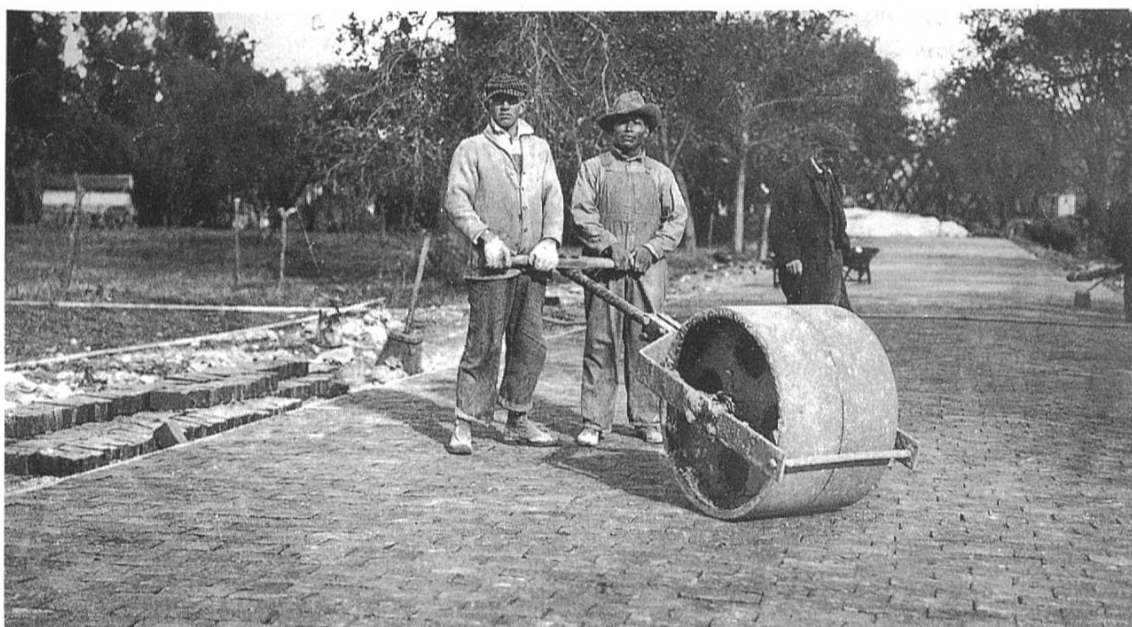
Abb. 6 Die Walze sorgt für eine tadellose Oberfläche.
