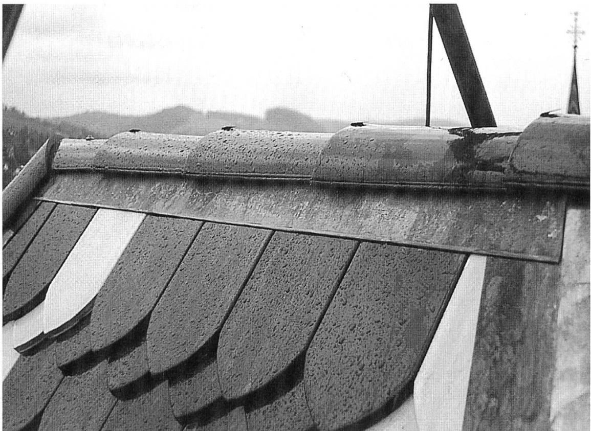
Abb.10 Firstdetail der Eindeckung von 1993.
