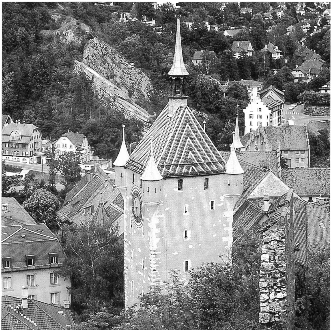
Abb. 2 Der Stadtturm in Baden mit dem alten Ziegeldach.
