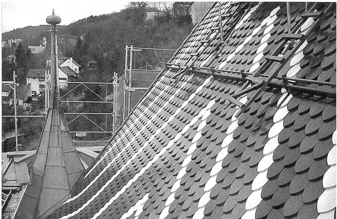
Abb. 17 Neugedeckte Dachfläche und Kupfer- helm des Erkers.
