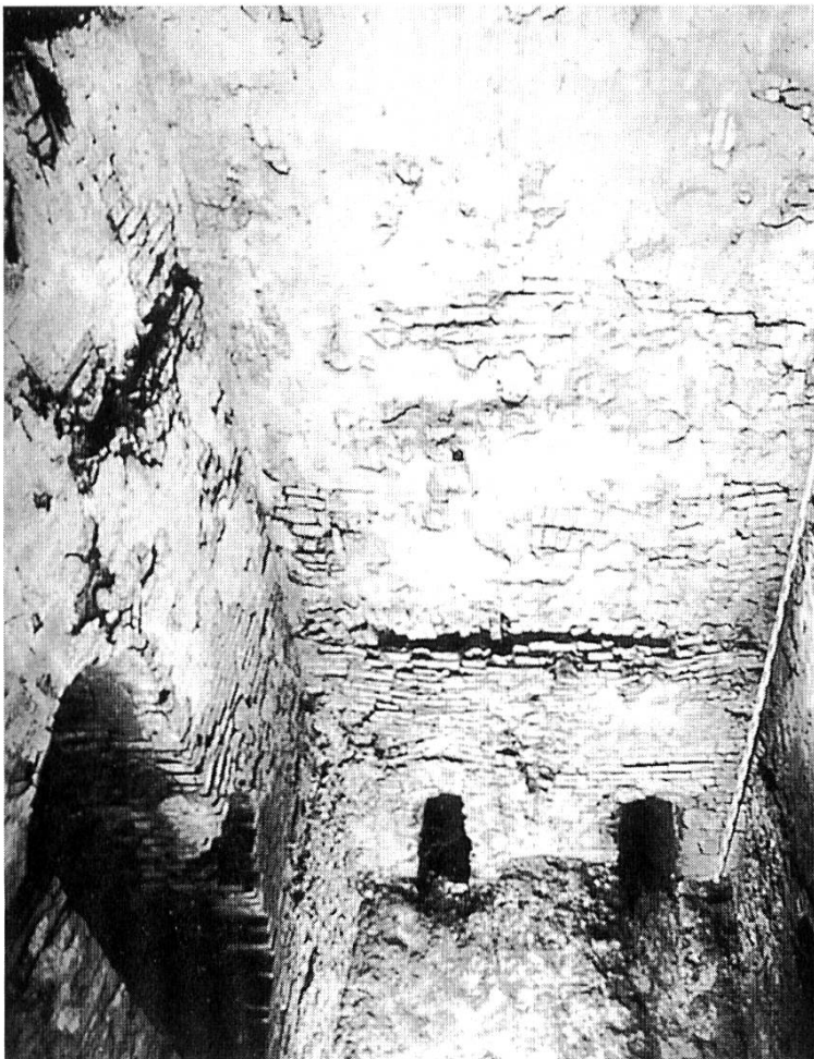
Abb. 5 Blick in den Brennraum des Ofens 2 mit den beiden Schürkanälen und der Beschickungsöffnung auf der linken Seite.
