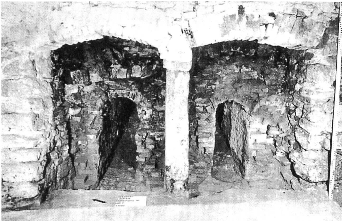
Abb. 6 Aussen- ansicht der Schürklöcher des grossen Ofens 2. Der Mittelpfosten stützt den Kaminhut des Rauch- abzuges.
