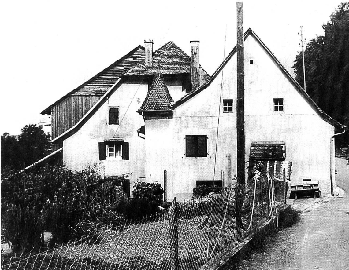
Abb. 1 Gebäude- komplex der ehemaligen Ziegelei Laufen, Ansicht gegen Osten.
