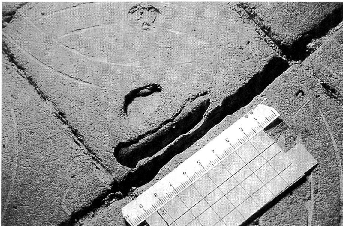
Abb. 1 Löcher in einer ornamentierten, stark abgenutzten Bodenplatte des Bebenhäuser Dormitoriums.
