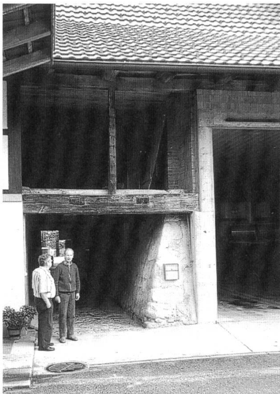
Abb. 3 Schüpbach BE: Die Aussen- mauer eines ehemaligen Ziegelofens stützt heute die Beton- wand einer Lastwagen- garage.
