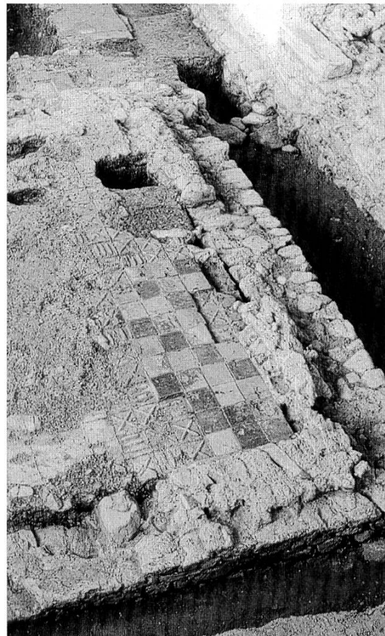
Abb. 17 Beromünster LU, Pfarr- kirche St. Stephan: Ausschnitt aus dem Chorboden von 1469. Hafrillen formten Kreuze und Stege in den Mörtel.
