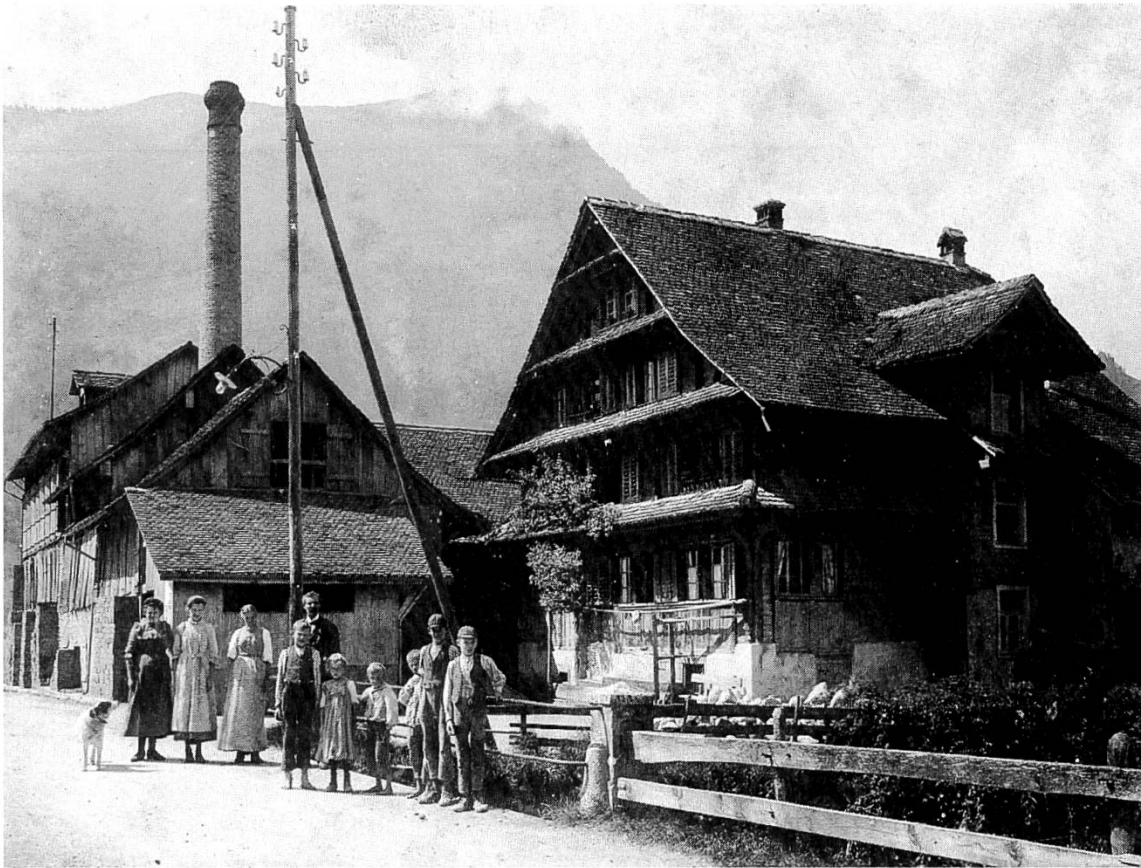
Abb. 3 Familie Aufdermaur vor der Ziegelhütte und dem Wohnhaus, um 1910.
