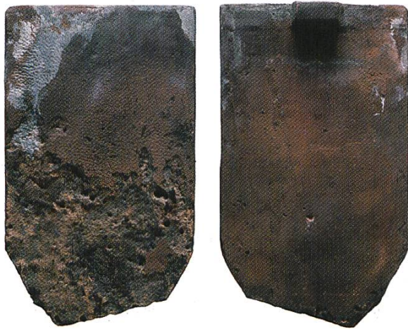
Abb. 11 Hirsau, St. Aurelius. Fragment eines Spitzschnittes für die Dachfläche. Lange Variante mit Lederabdruck (vgl. Abb. 27). Vorder- und Rückseite, 1:10.
