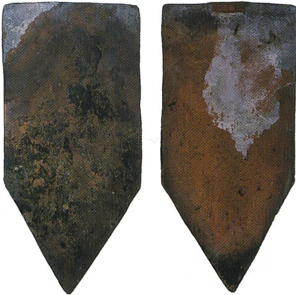
Abb. 9 Hirsau, St. Aurelius. Spitzschnitt für die Dachfläche, lange Variante. Vorder- und Rückseite, 1:10.
