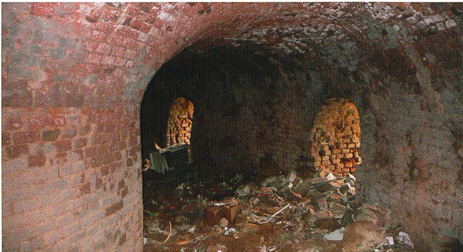
Leoben in der Obersteiermark A, ehemalige Ziegelei Dörfler: Blick in die Biegung des ovalen Ringofens.
