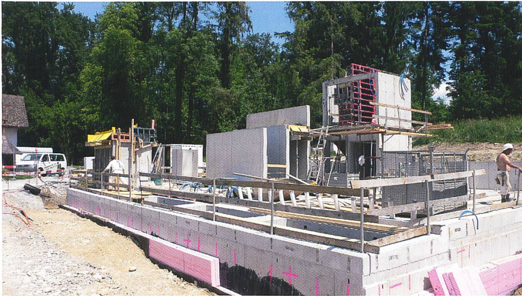
Abb. 1 Cham, Ziegelei- Museum, Neubau: Betonelemente in UG, Treppenhaus und Liftschacht. Foto Jürg Goll, Ziegelei-Museum.
