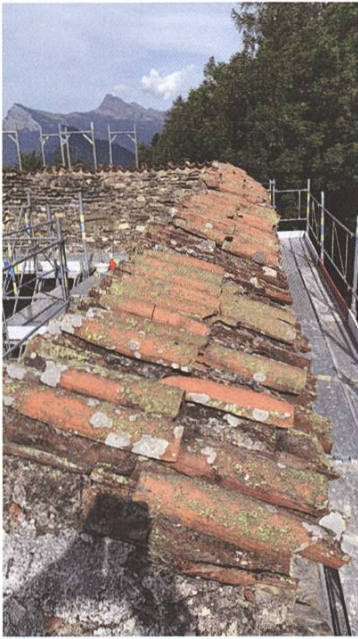
Jenins GR, Burgruine Neu-Aspermont. Abdeckung der Mauerkronen mit spätmittelalterlichen Hohlziegel.
