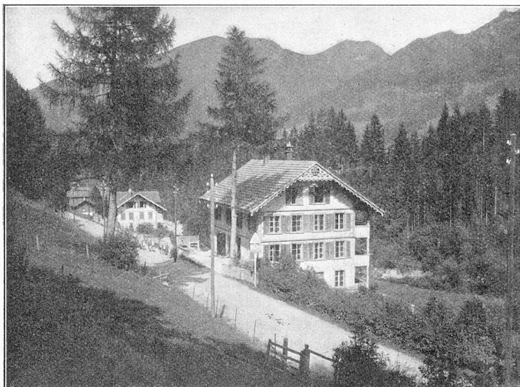
Altersheim Zweisimmen. — Asile de vieillards Zweisimmen.
