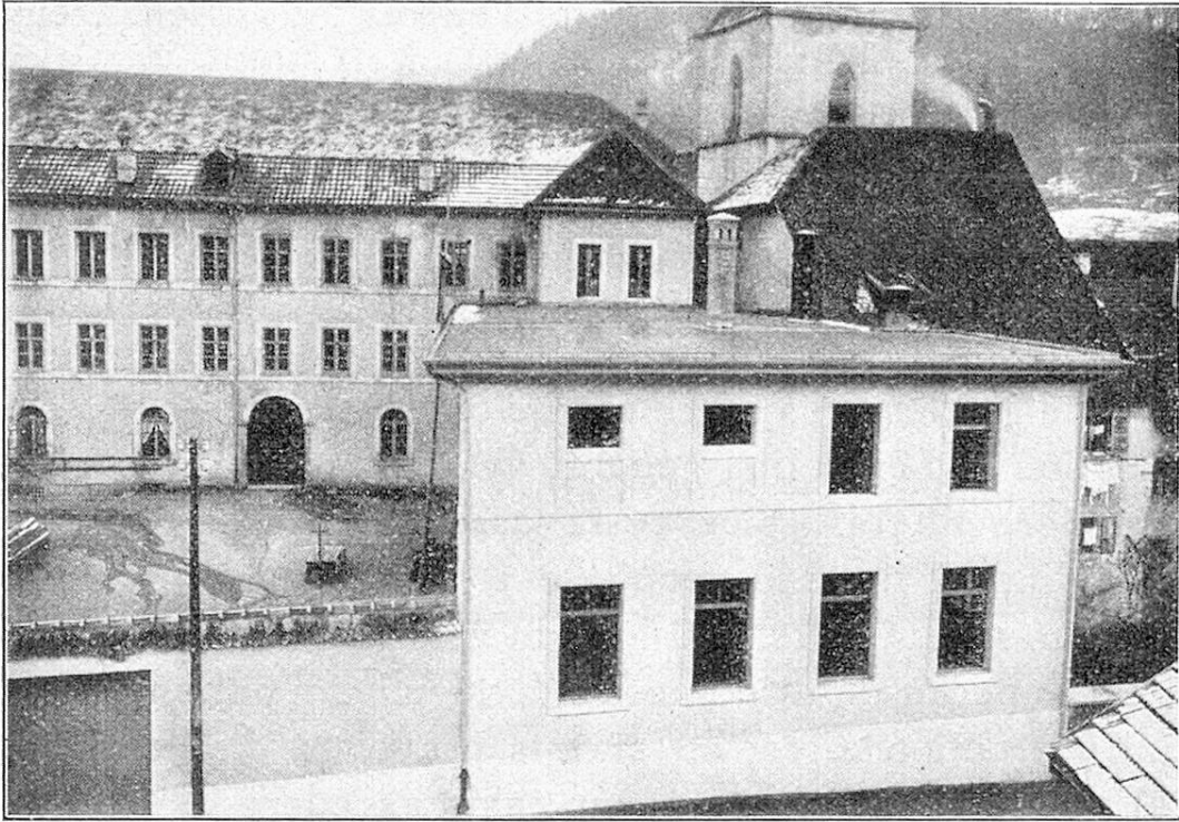
Atelier en construction. — Im Rohbau fertige Werkstatt.
