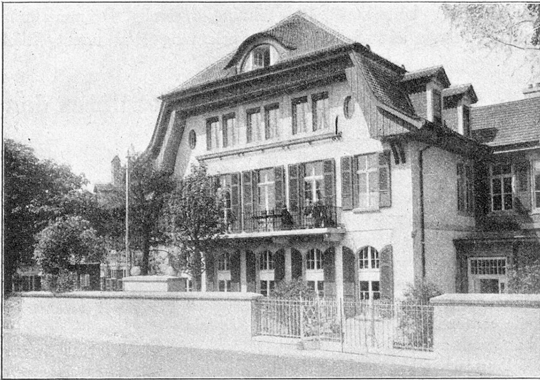
Neuer Mittelbau des Greisenasyls Bern.
