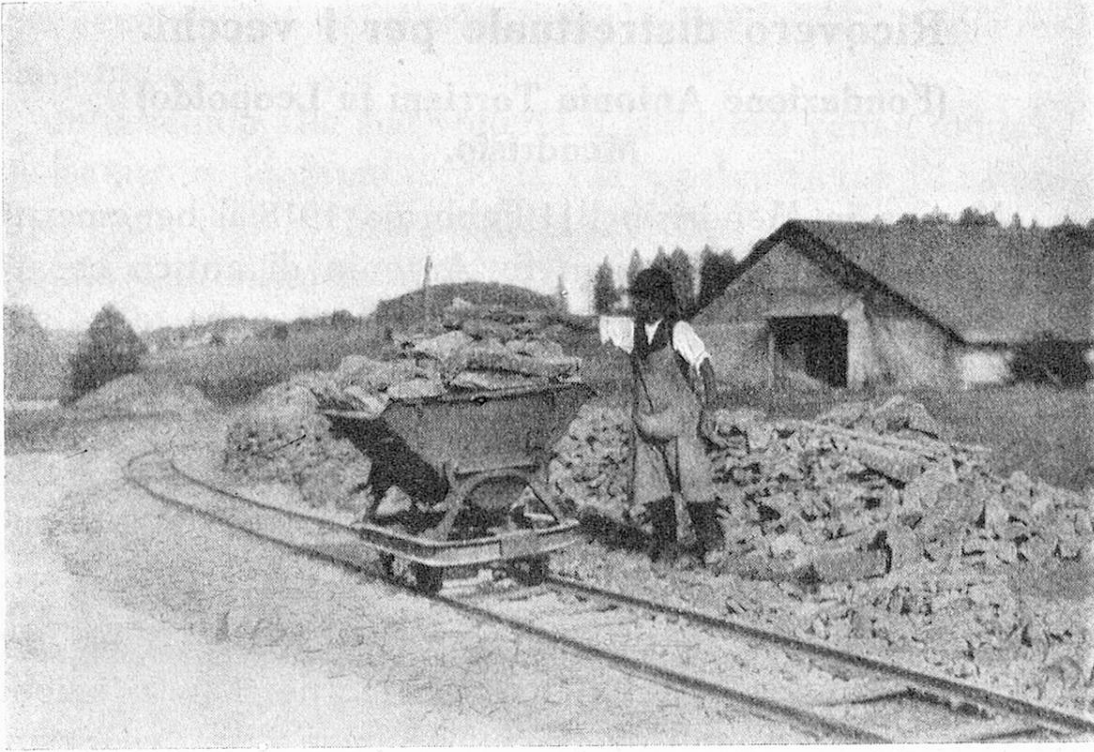
Construction d'une route par des chômeurs.
