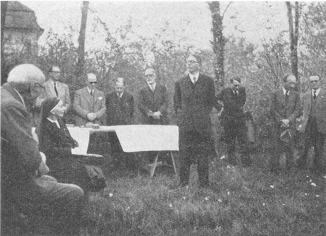
Mr. le Président du Conseil d'Etat de Genève Albert Picot prononçant un discours au premier coup de pioche départ de la construction de 38 logements pour couples âgés 22 avril 1947 à gauche Mr. John Jaques, président d'honneur du Comité cantonal, âgé de 95 ans
