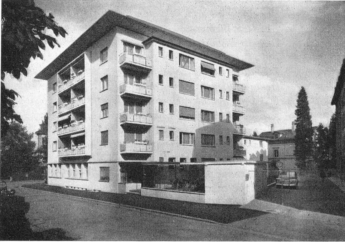
Ansicht von der Hallerstrasse aus
