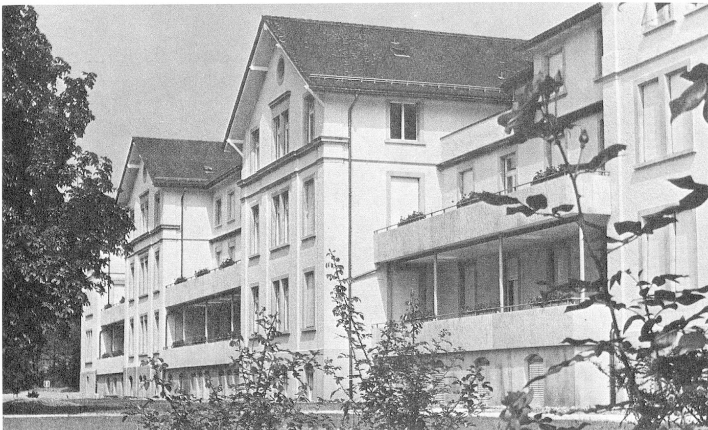
Der prächtige Baumbestand im Park des ehemaligen Spitals lässt Durchblicke auf Hauptstrasse und Obersee frei. In den zwei Obergeschossen liegen die Patientenzimmer. Der Dachstock mit Personalzimmern und Verwalterwohnung kann in einem spätern Zeitpunkt ebenfalls in eine Patientenabteilung umgewandelt werden.
