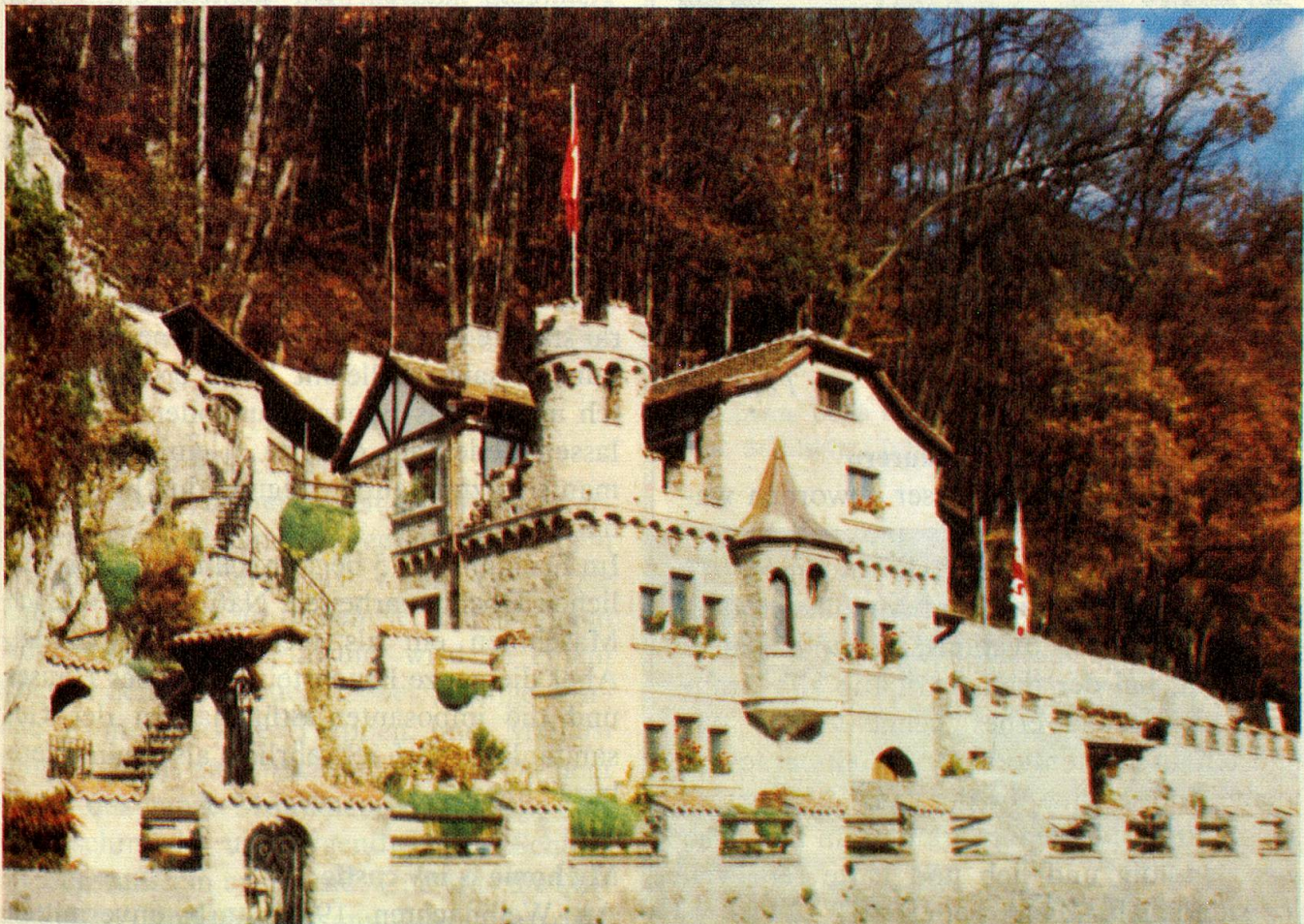
So präsentiert sich dem überraschten Besucher das «historische» Schloss an der Amdenerstrasse in Weesen, das erstaunliche, 1975—1977 entstandene Werk eines 73jährigen Mannes.
