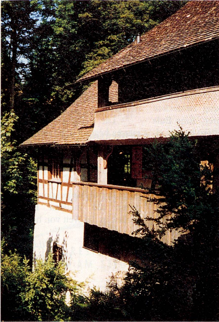
Die Kobesenmühle, geborgen im Schutz der Bäume.
