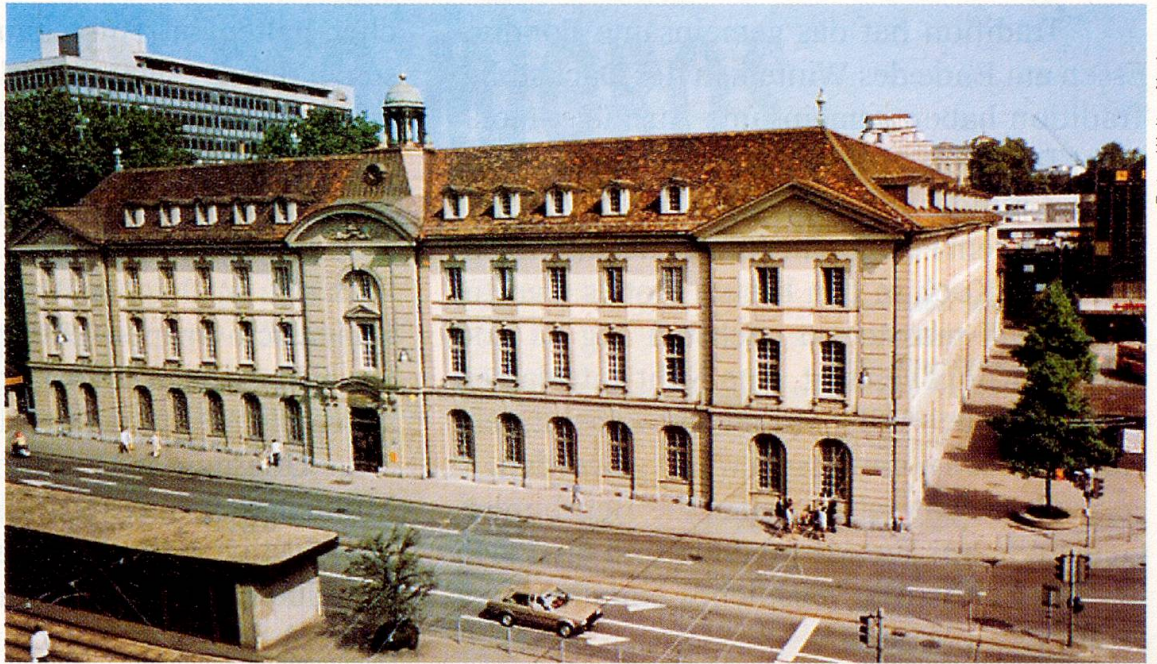
Die Südseite des Burgerspitals in Bern, rechts knapp sichtbar der Hauptbahnhof.
