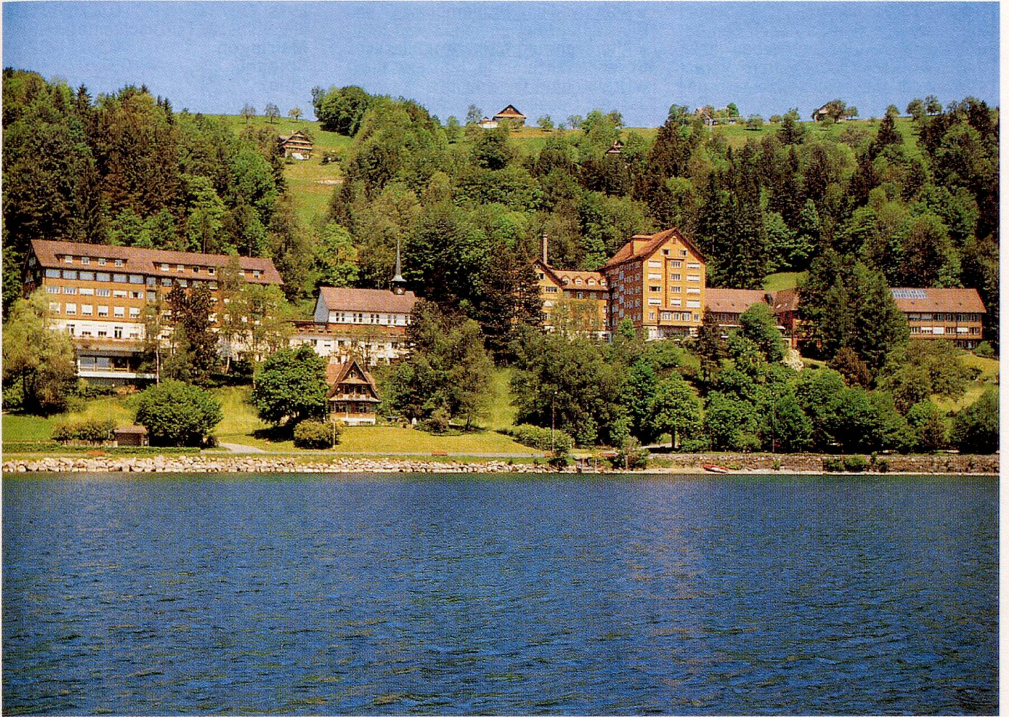
Ländli-Gesamtansicht v.l.n.r. Diakonissen-Mutterhaus mit Hallenbad, Kirche, Kurhaus, Haus «Birkenrain»
