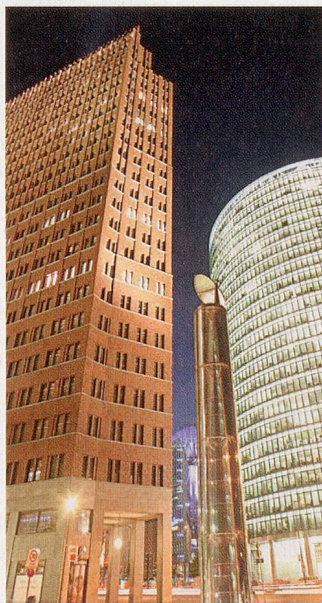
Erstrahlt im Lichterglanz: das Gebäude der Deutschen Bundesbahn am Potsdamer Platz in Berlin.
