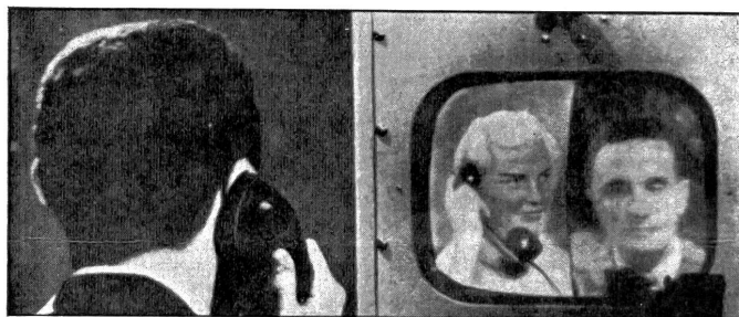
Das Fernsehtelefon ist da! In Amerika kann man es sich jetzt einrichten lassen. Besitzt es der Gesprächspartner ebenfalls, so kann man sich jetzt während des Telefonierens sehen. In der Zwischenzeit dient es als gewöhnlicher Telefon-Fernsehempfänger.
